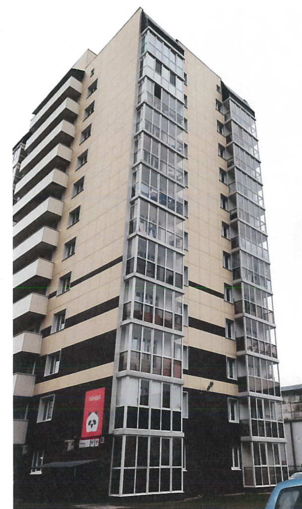
Фасад с улицы Рабочая (существующее положение)
