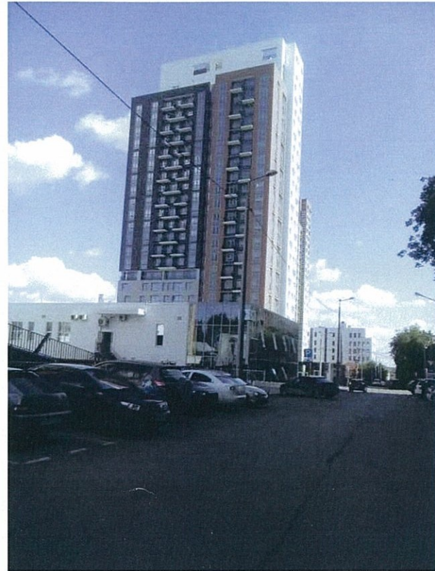
Существующее состояние фасадов (фотофиксация)
