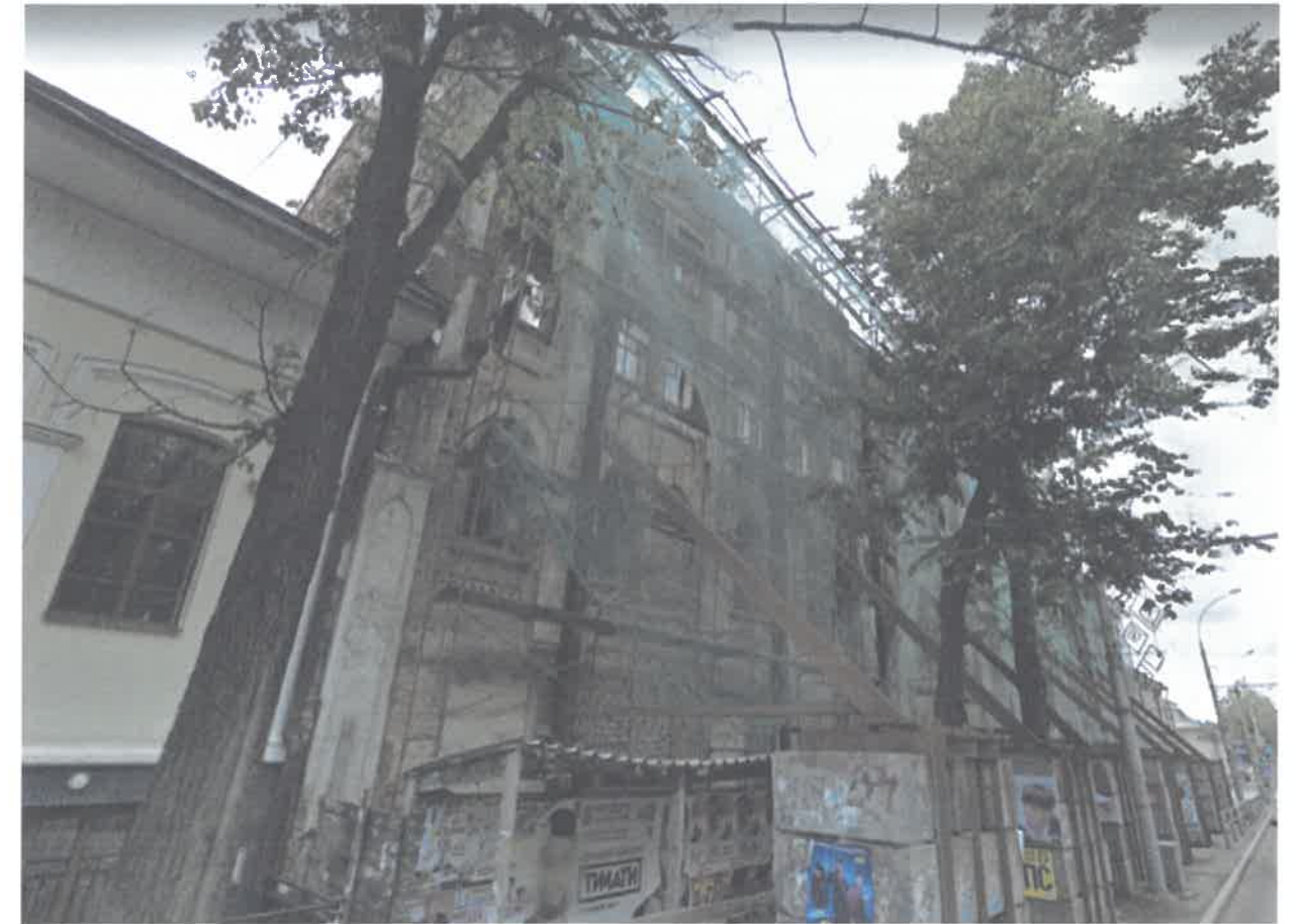
Главный фасад до проведения работ с угла улиц Сибирская и Краснова
