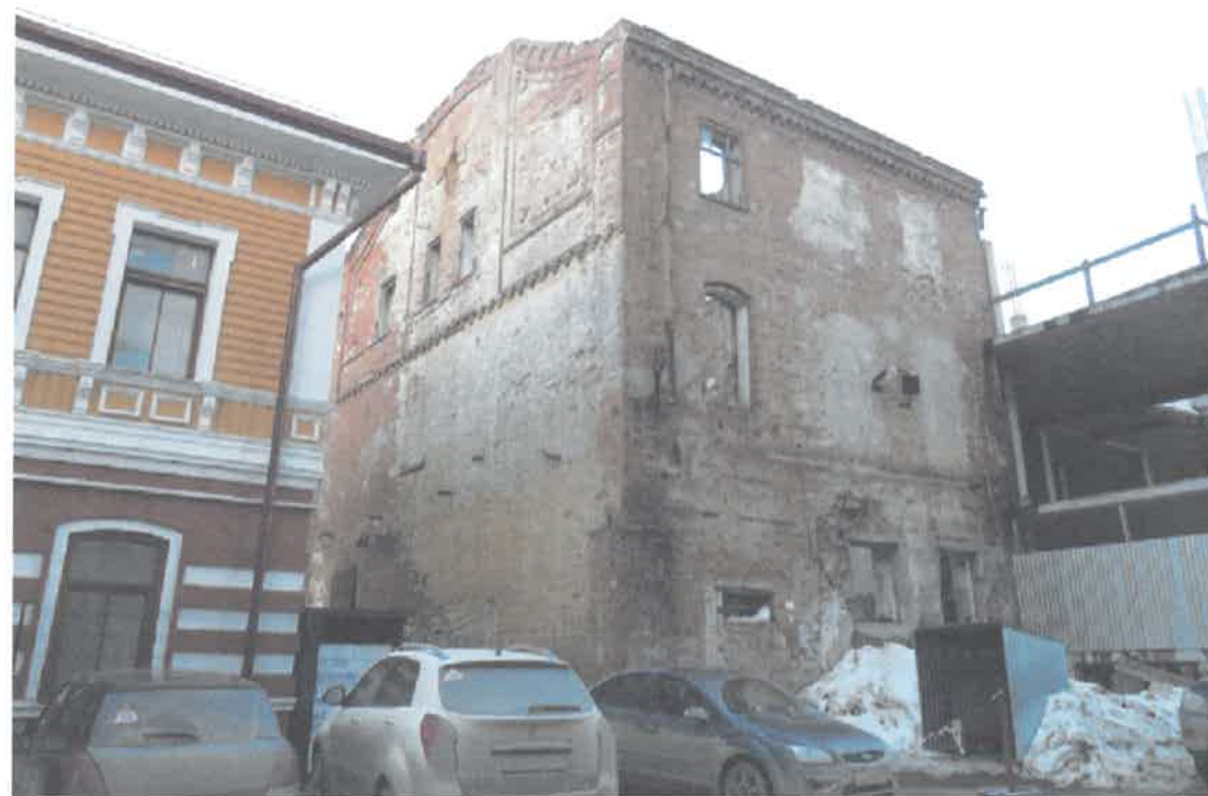
Общий вид 3-х этажной части здания со двора со стороны ул. Пушкина
