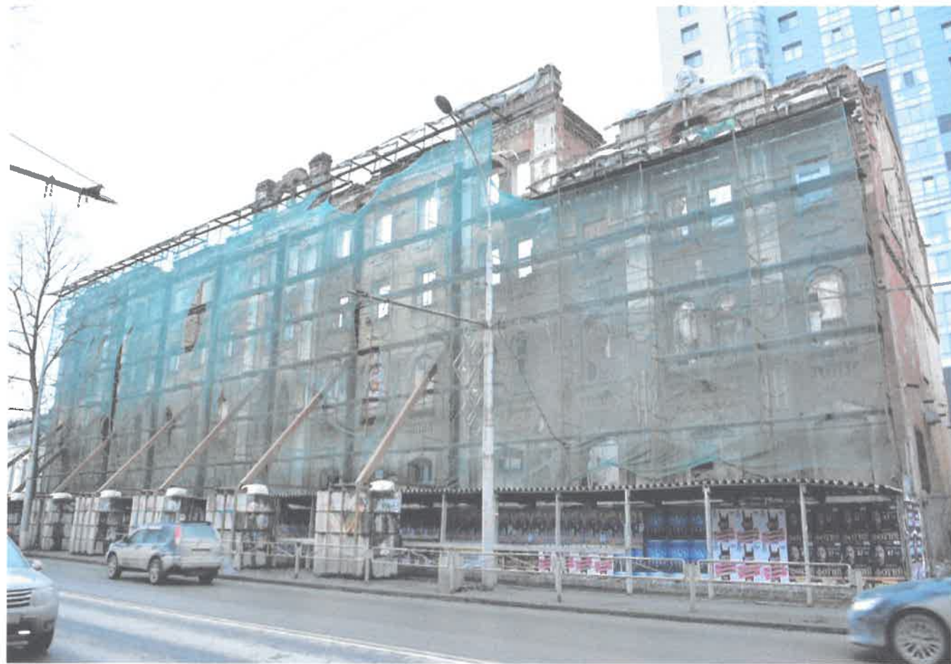
Главный фасад до проведения работ с угла улиц Сибирская и Пушкина
