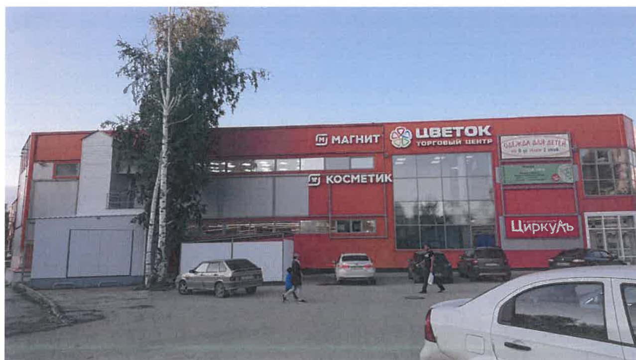
Существующее состояние бокового фасада
