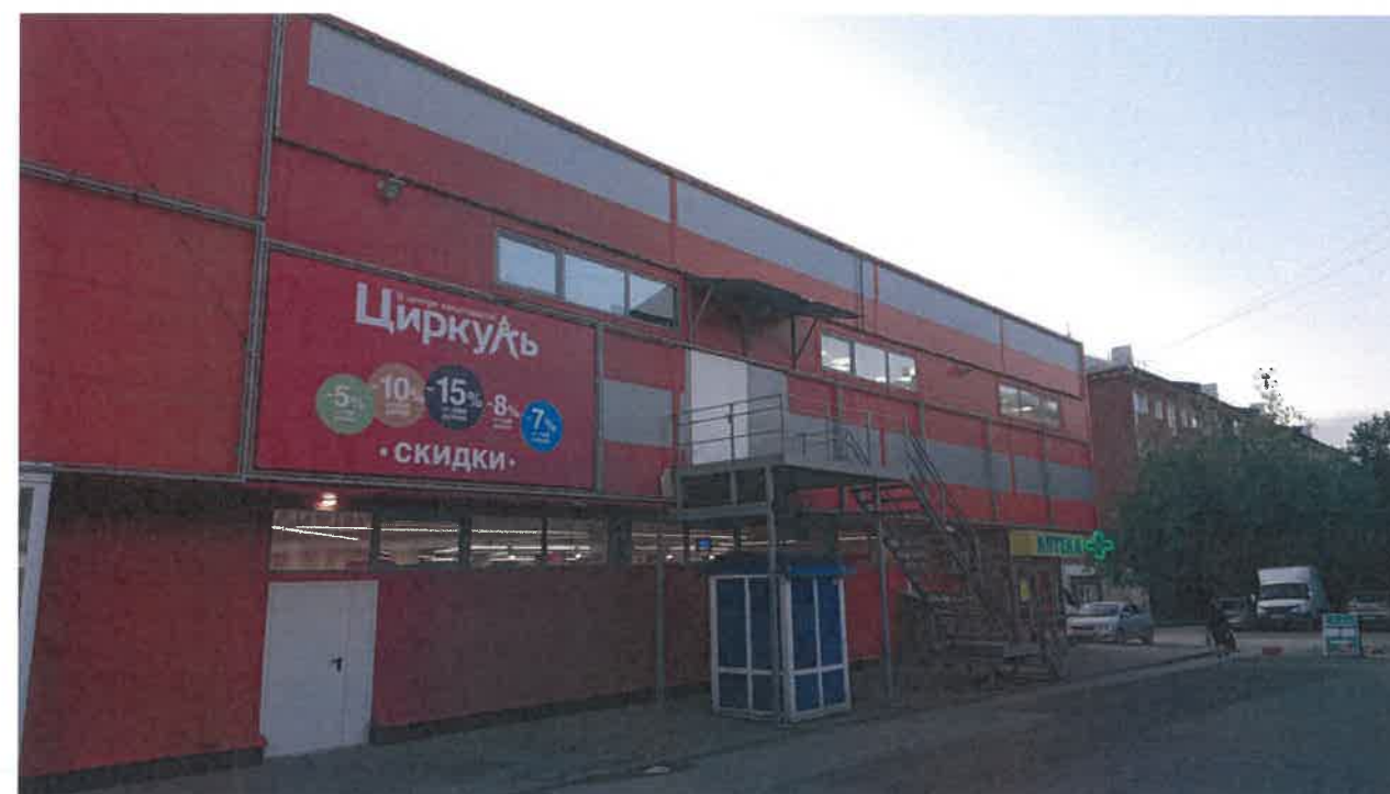
Существующее состояние главного фасада
