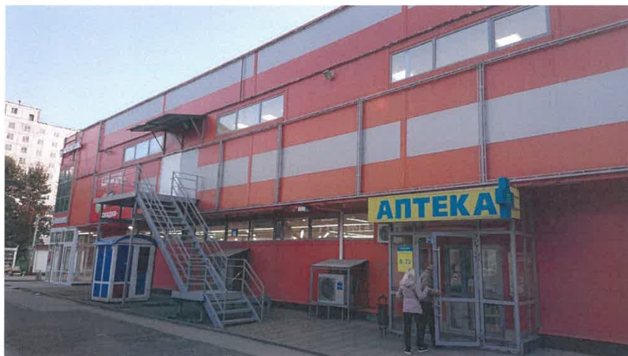
Существующее состояние главного фасада
