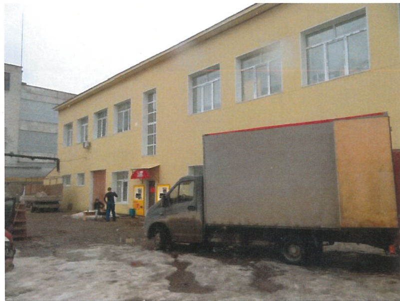
Существующее состояние дворового фасада Д - Б
