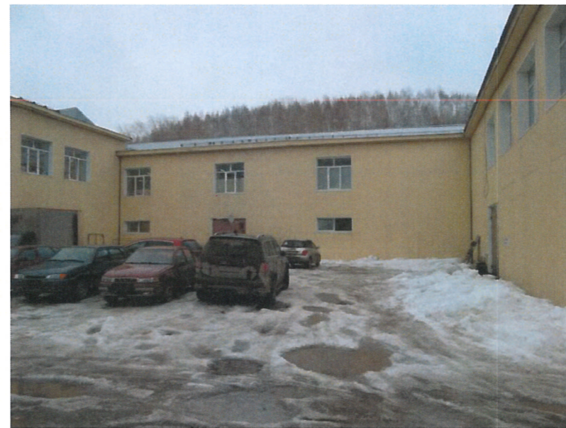
Существующее состояние дворового фасада 3 - 2
