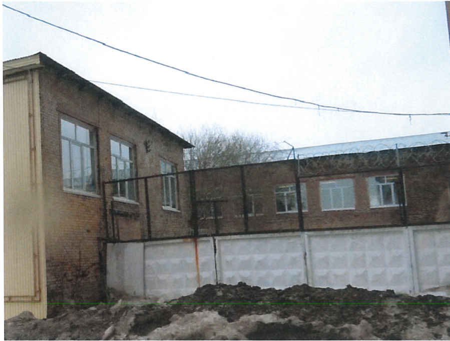
Существующее состояние дворовых фасадов 6 - 5 и Б - Д
