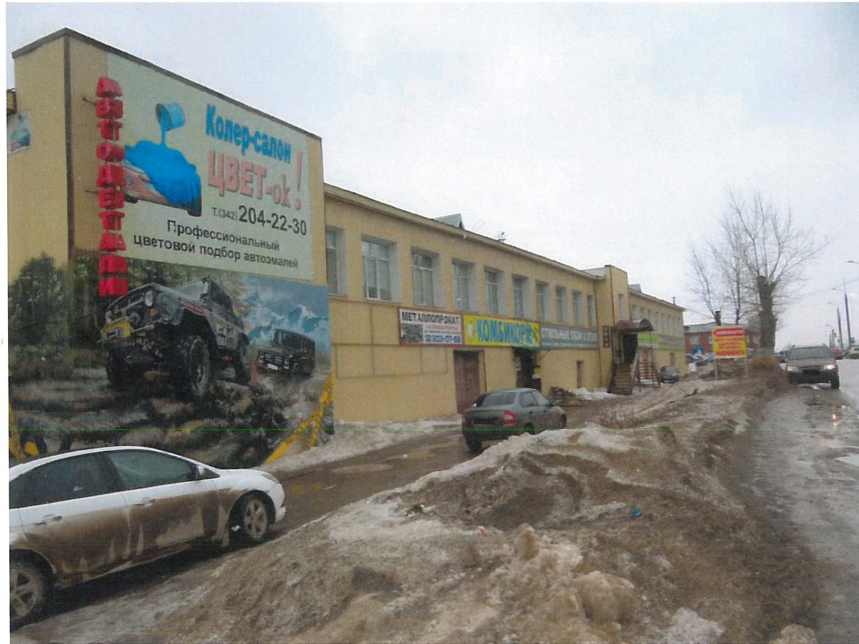
Существующее состояние главного фасада 1 - 6
