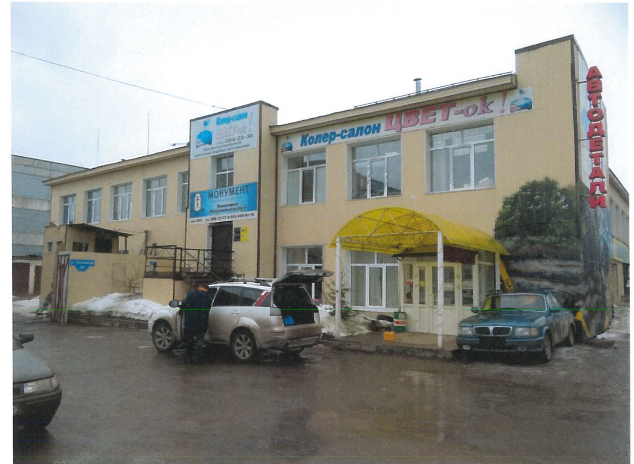
Существующее состояние бокового фасада Г - А
