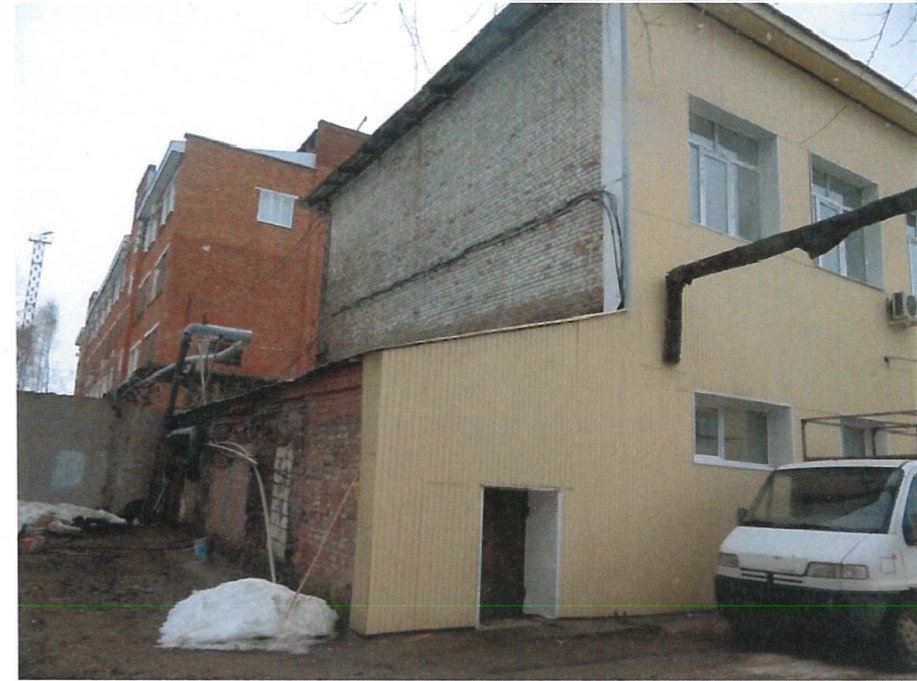
Существующее состояние дворового фасада 4 - 3
