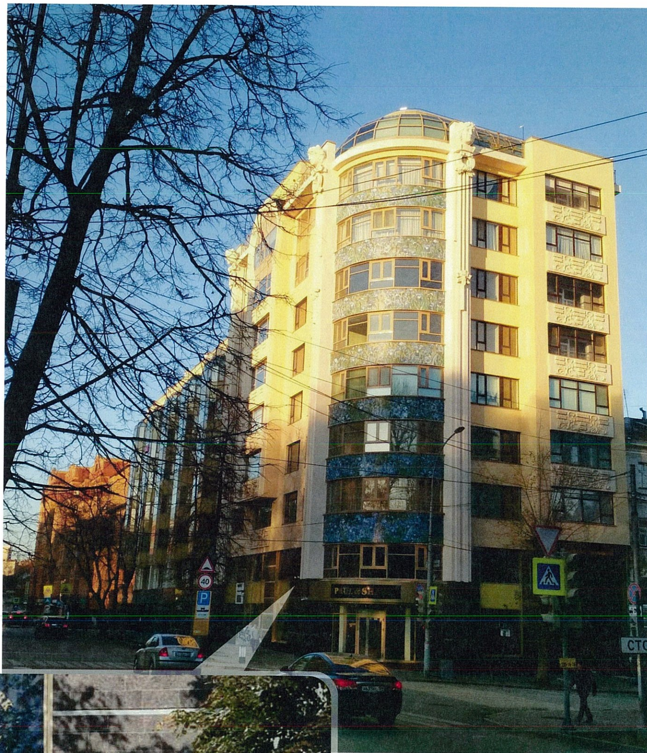
Фасад с улицы Сибирская (существующее положение)
