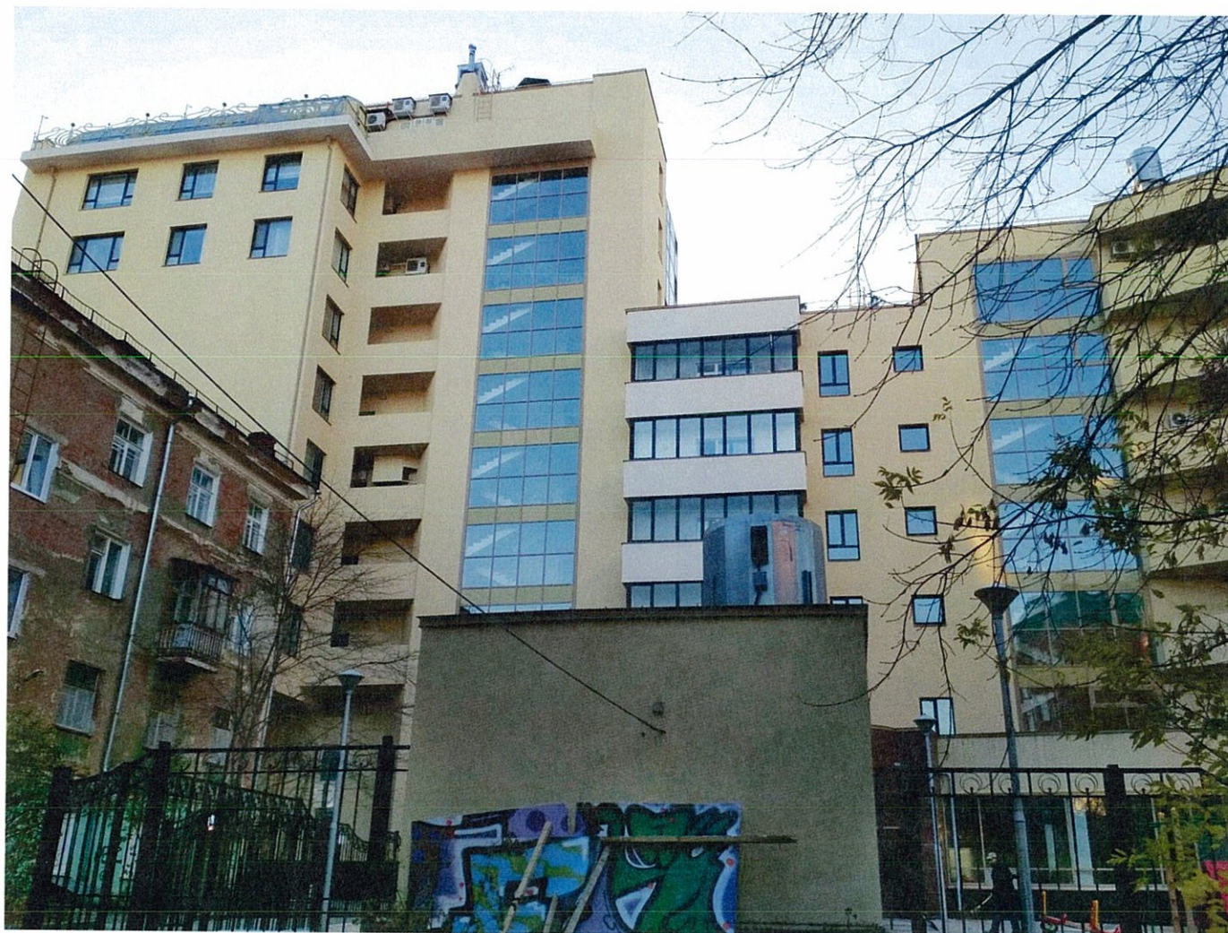
Дворовой фасад (существующее положение)
