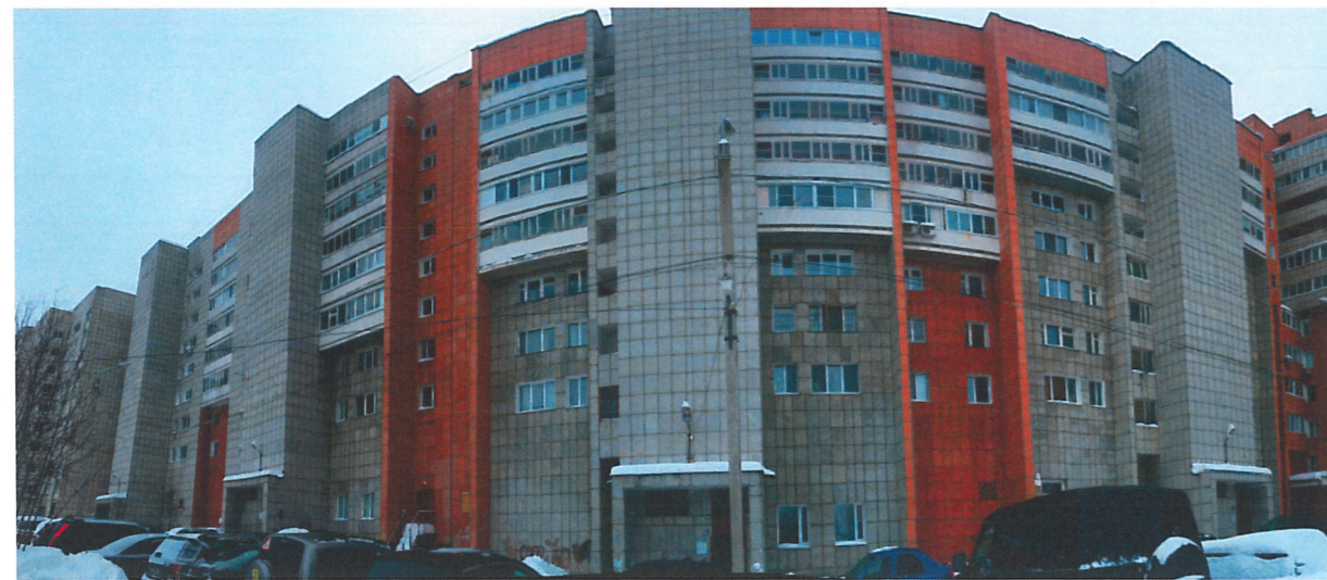
Существующее состояние дворового фасада (фотофиксация).
