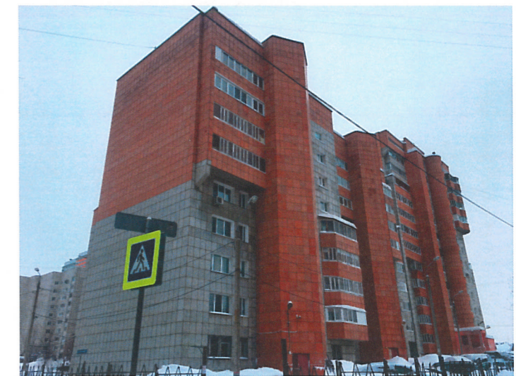
Существующее состояние бокового фасада (фотофиксация).
