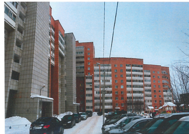
Существующее состояние дворового фасада (фотофиксация).
