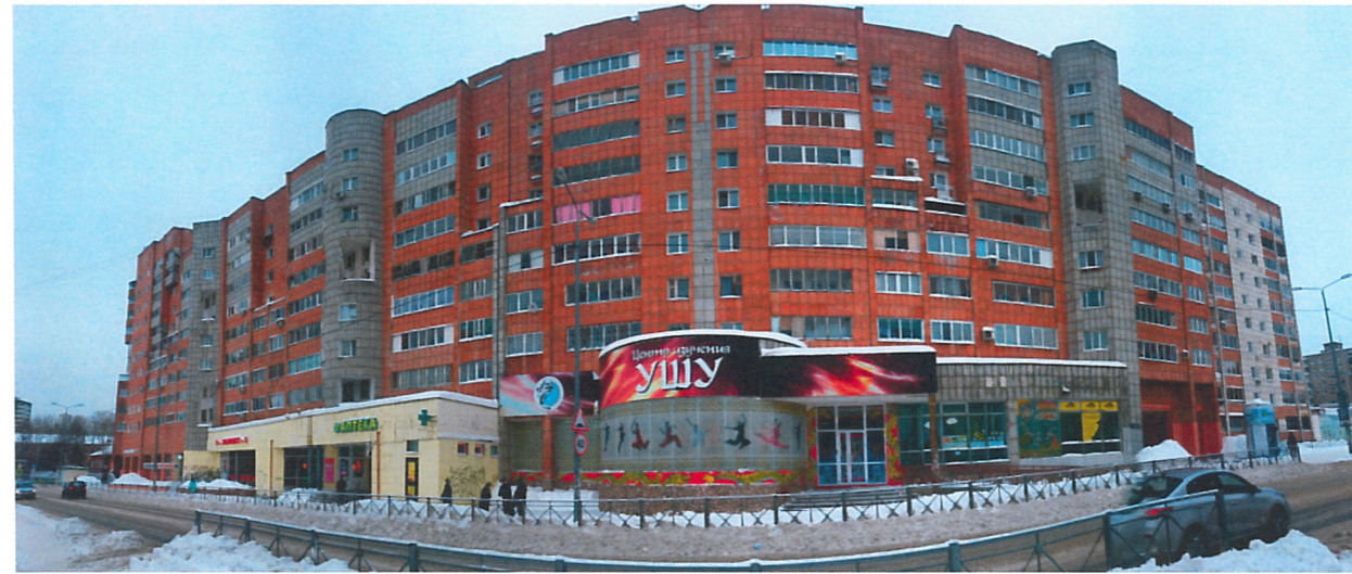
Существующее состояние главного фасада (фотофиксация).
