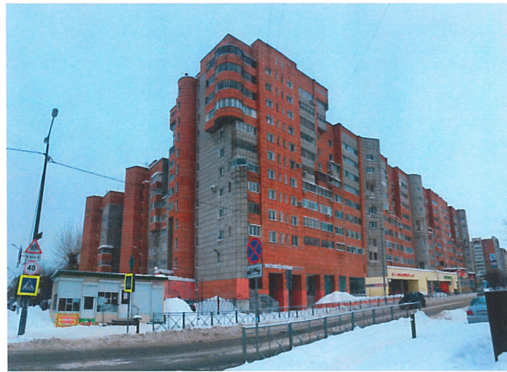
Существующее состояние главного фасада (фотофиксация).
