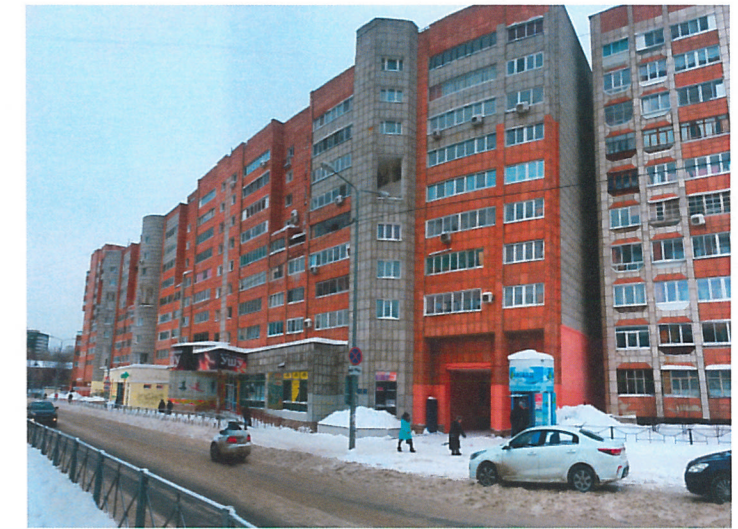
Существующее состояние главного фасада (фотофиксация).
