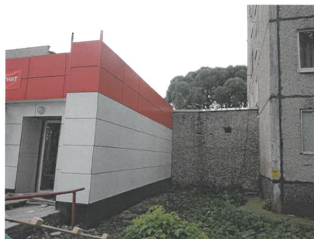
Существующее состояние боковых фасадов
