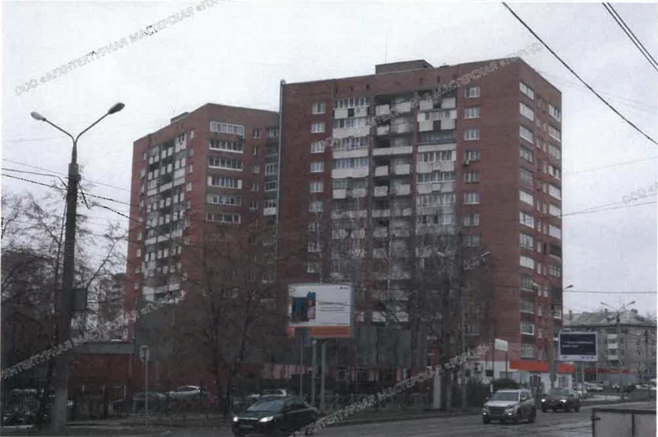
Дворовой фасад в осях 5-1
