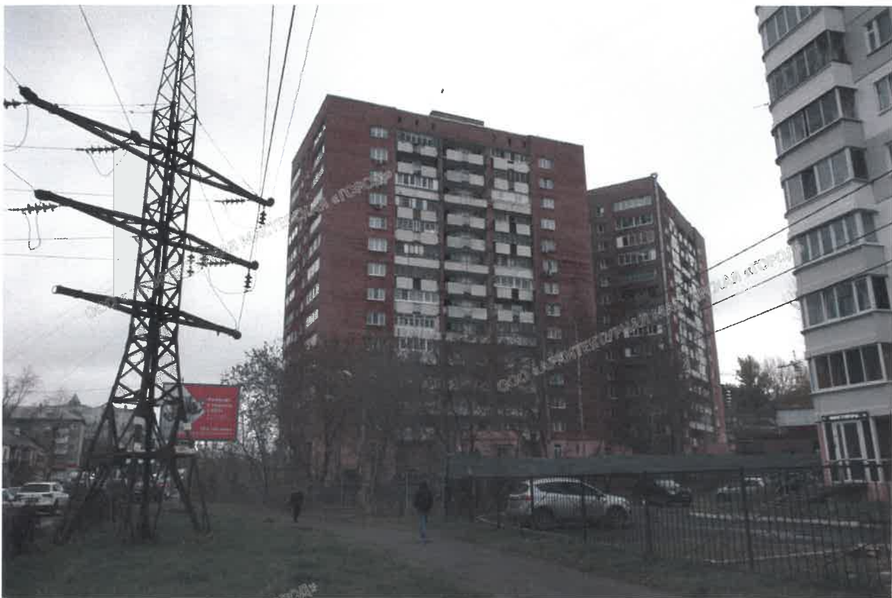
Дворовой фасад в осях 5-1
