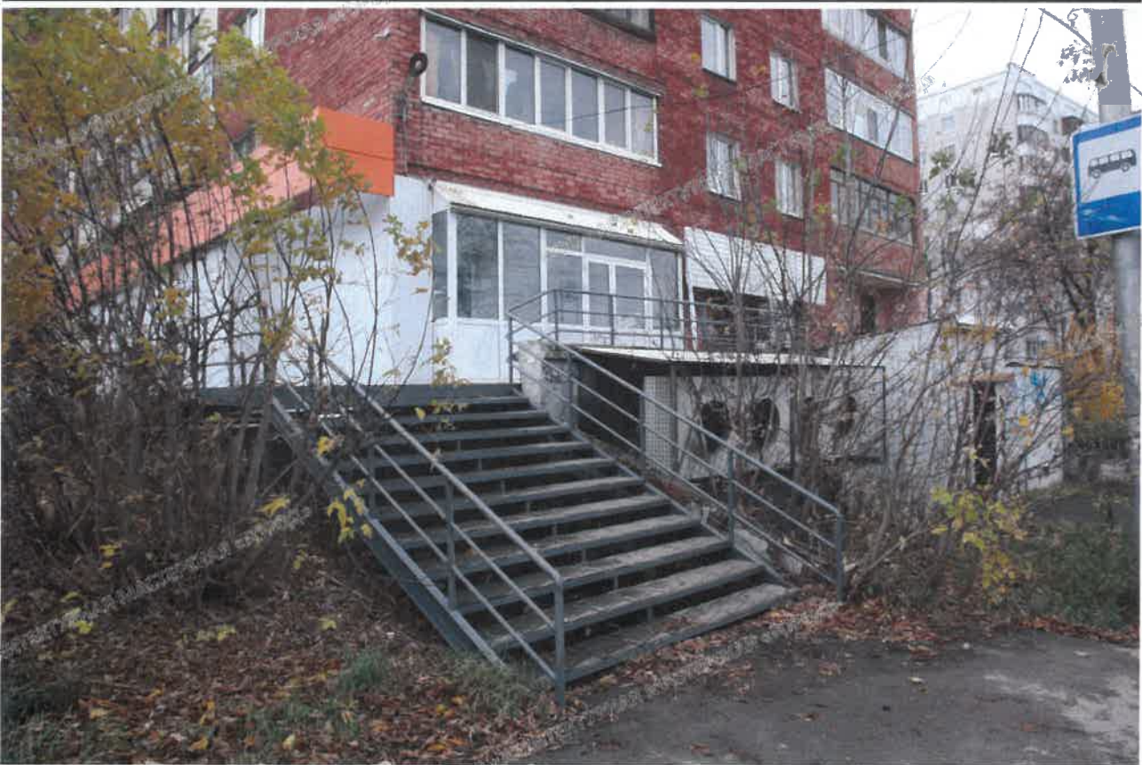
Фрагмент бокового фасада в осях А-В
