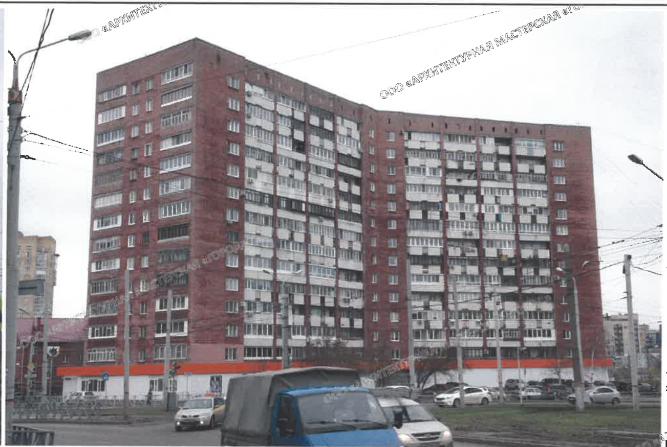
Главный фасад в осях 1-5
