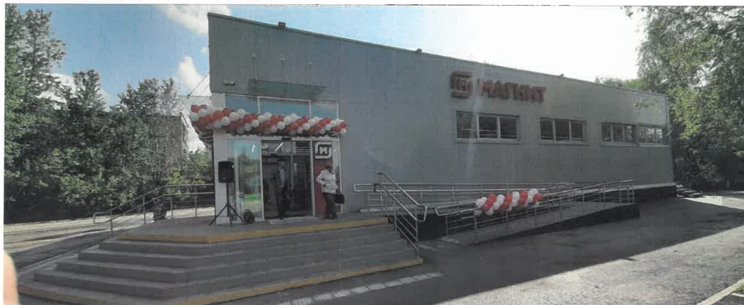
Существующее состояние главного фасада
