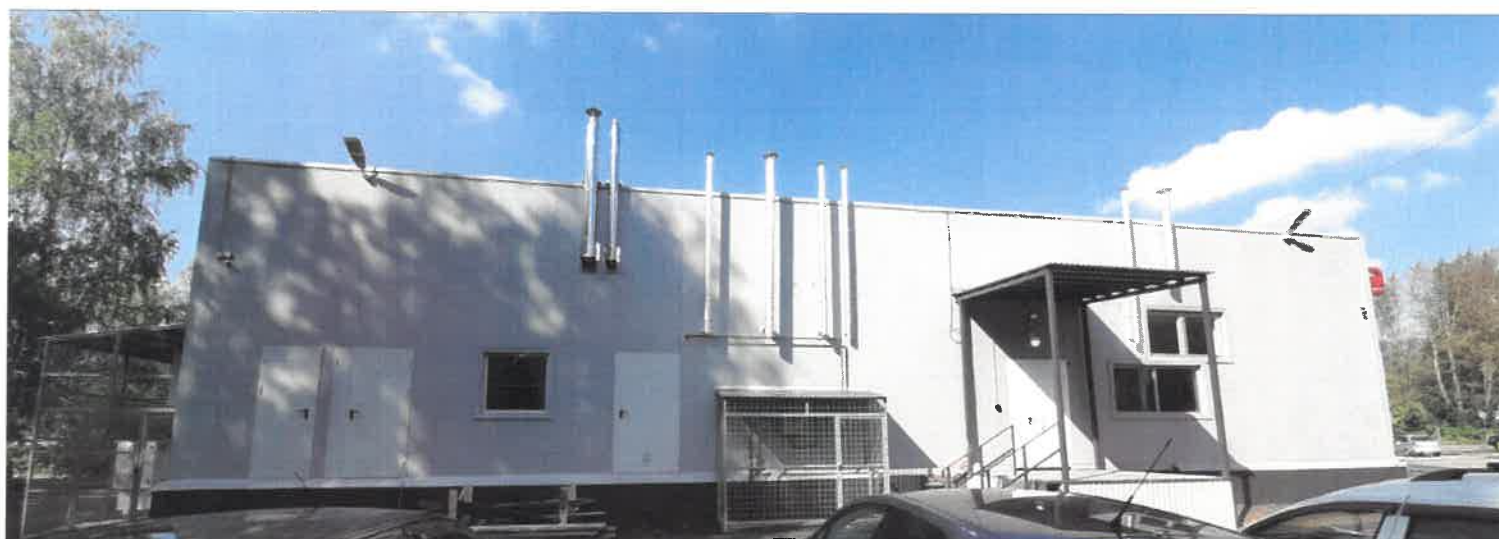
Существующее состояние дворового фасада
