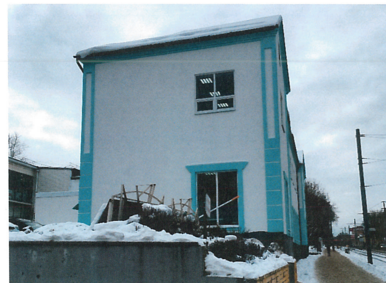
Существующее состояние бокового фасада (фотофиксация).
