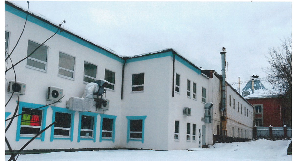
Существующее состояние бокового фасада (фотофиксация).
