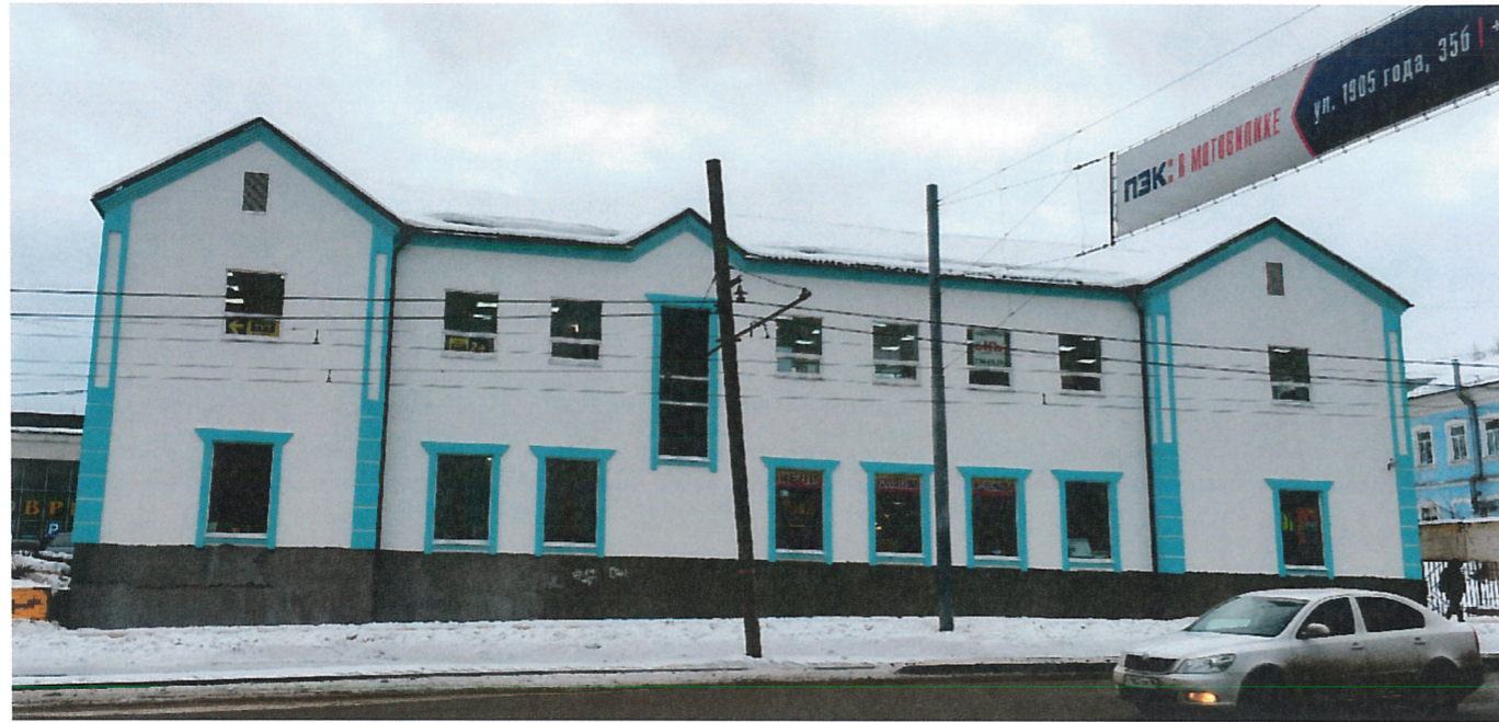
Существующее состояние главного фасада (фотофиксация).
