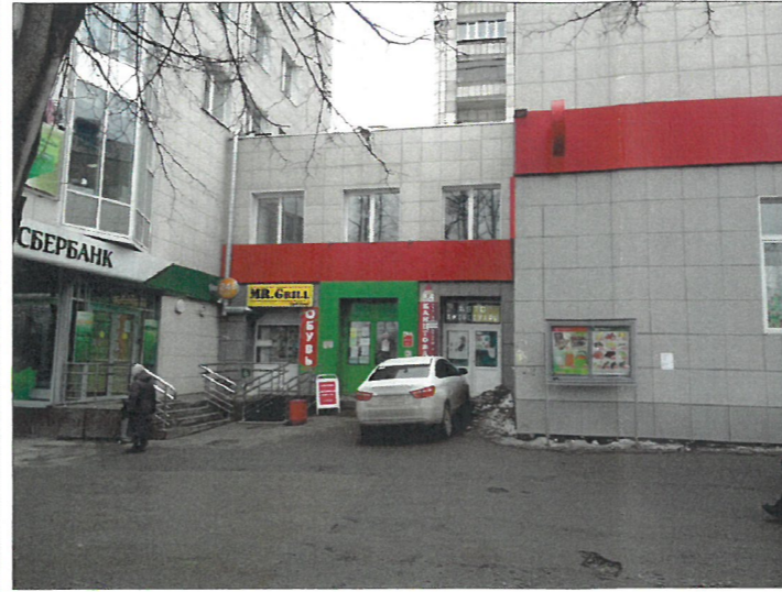
Главный фасад в осях 1-4
