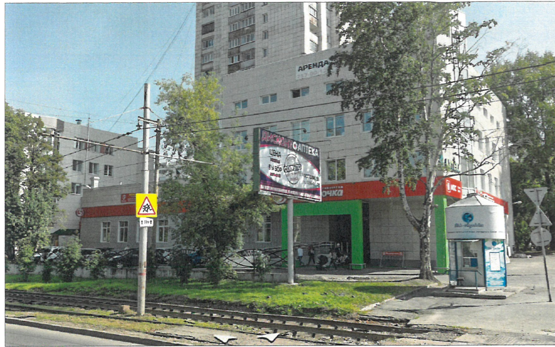
Главный фасад в осях 1-4
