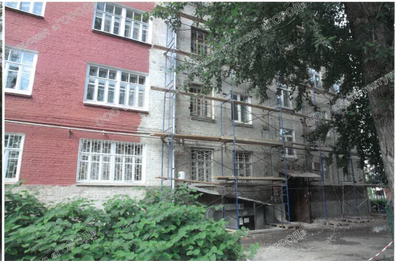
Фрагмент дворового фасада в осях 2-1
