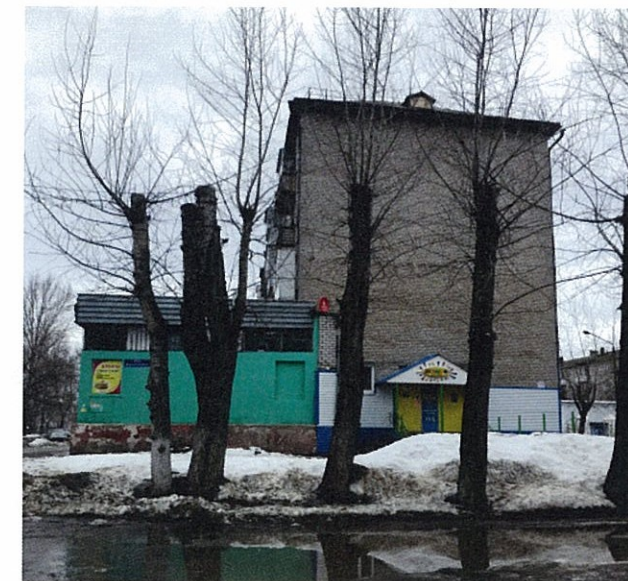
Боковой фасад с улицы Генерала Панфилова (существующее положение)
