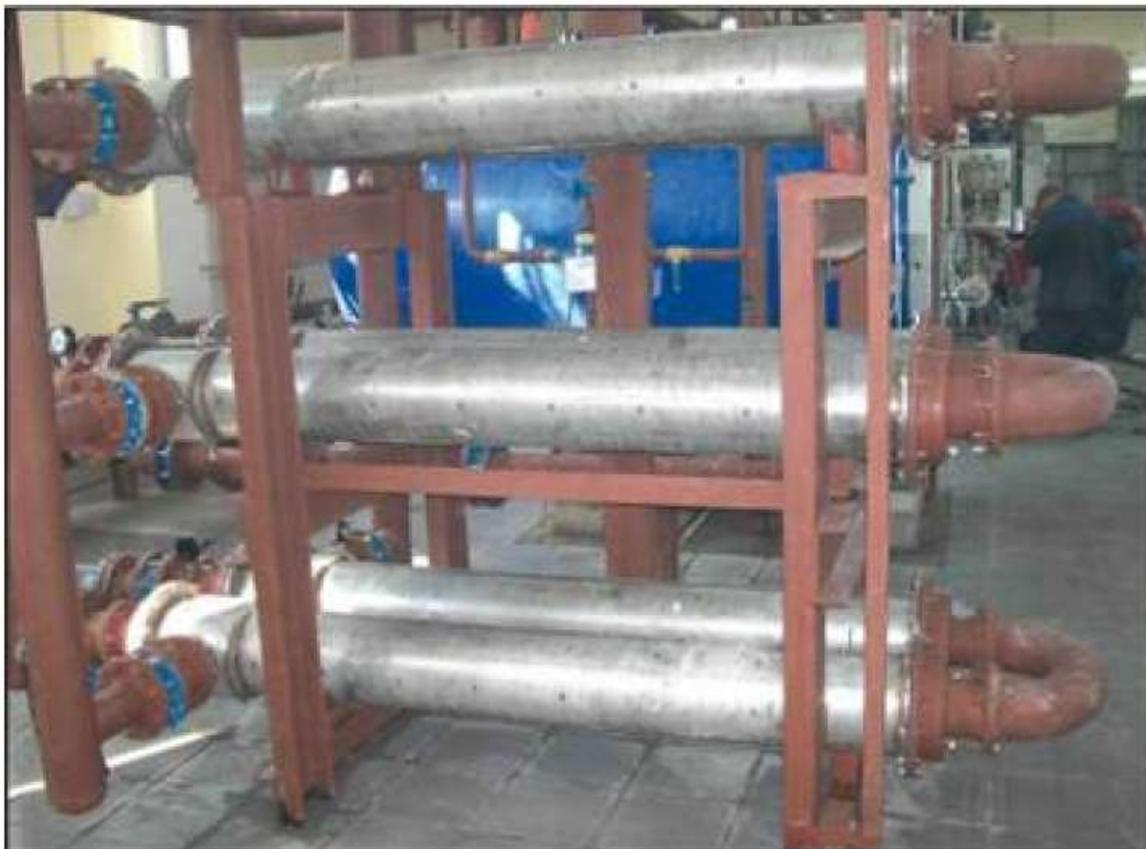
**Рисунок 7 - Теплообменники ВВПИ в котельной МУП "Теплосервис"**
