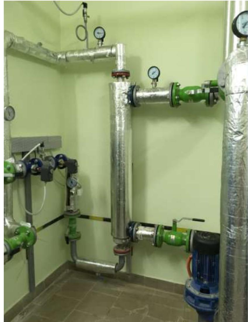
**Рисунок 8 - Элементы схемы ИТП на базе кожухотрубных теплообменных аппаратов**
