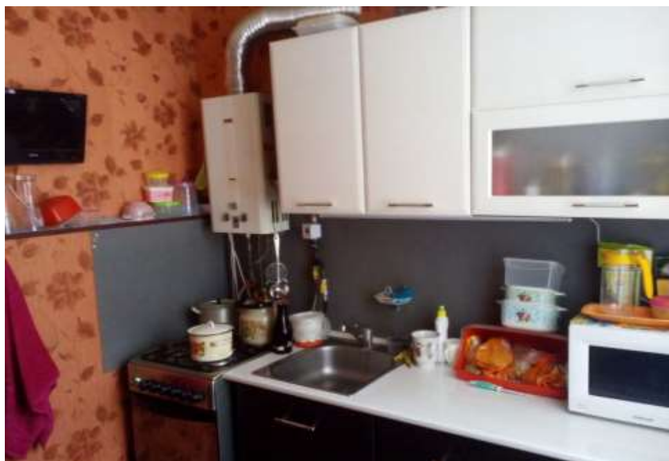
Рисунок 54 – Размещение газовых колонок в квартирах
