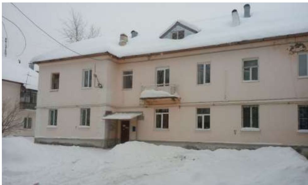
Рисунок 53 – Жилой дом ул. Белозерская , 13
