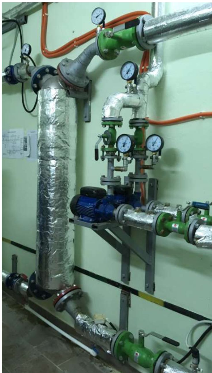
Рисунок 8 - Элементы схемы ИТП на базе кожухотрубных теплообменных аппаратов
