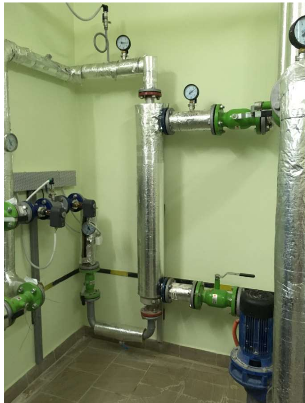
Рисунок 8 - Элементы схемы ИТП на базе кожухотрубных теплообменных аппаратов
