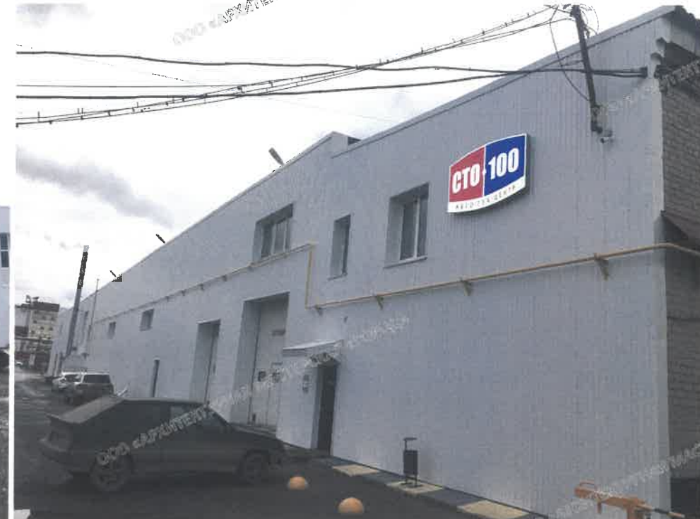
Боковой фасад в осях 1-2
