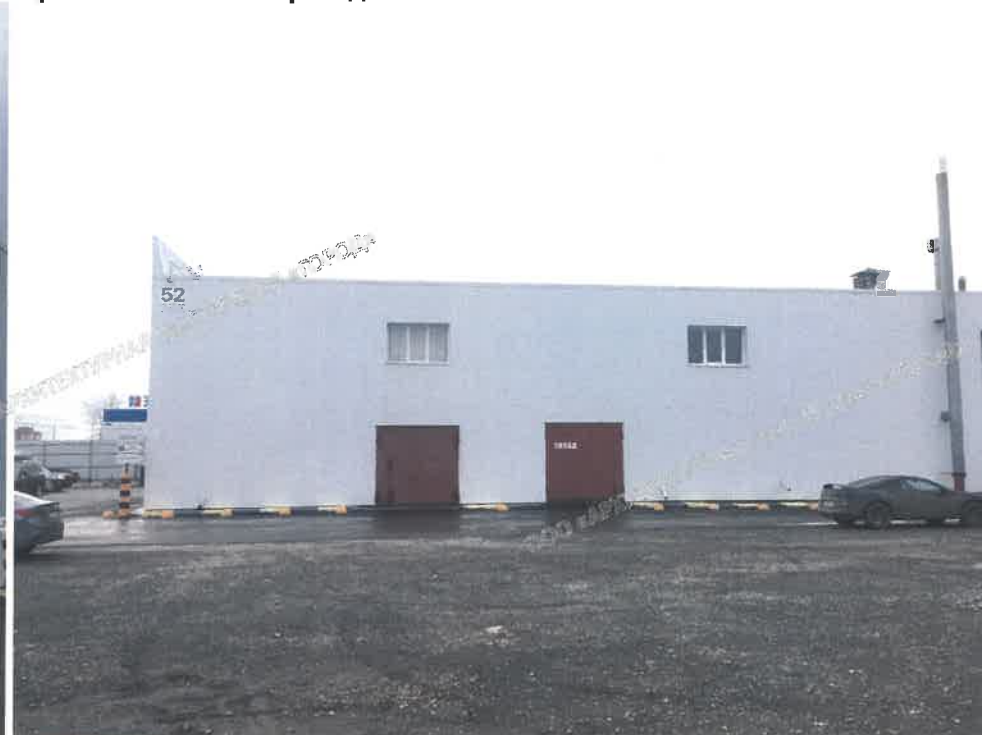
Фрагмент бокового фасада в осях 1-2
