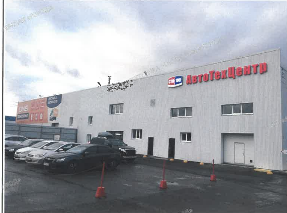
Главный фасад по ул. Хлебозаводской в осях Б-А
