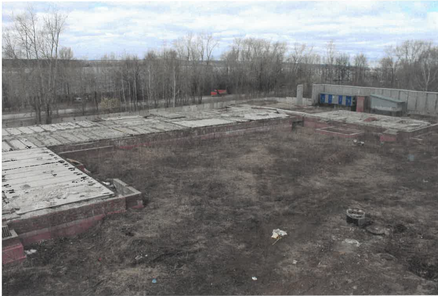
Существующее состояние (фотофиксация)
