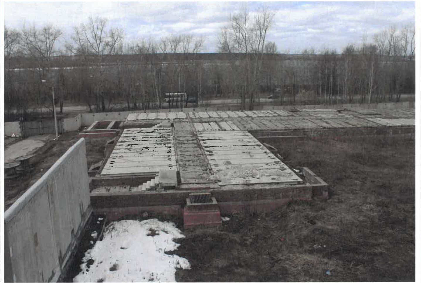
Существующее состояние (фотофиксация)
