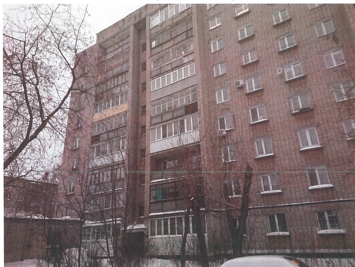
Существующее состояние центрального фасада (подъезд жилого дома)
