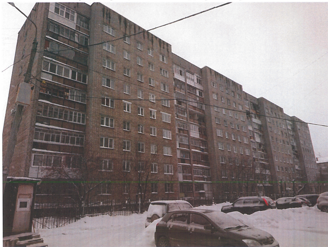
Существующее состояние дворового фасада
