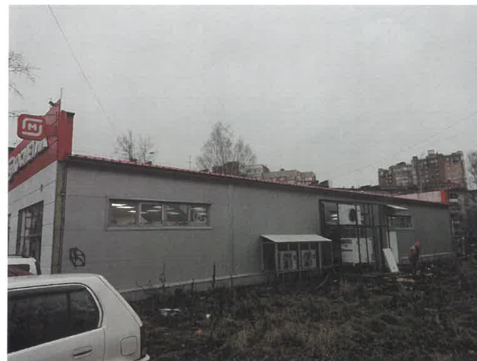
Существующее состояние бокового фасада (фотофиксация)
