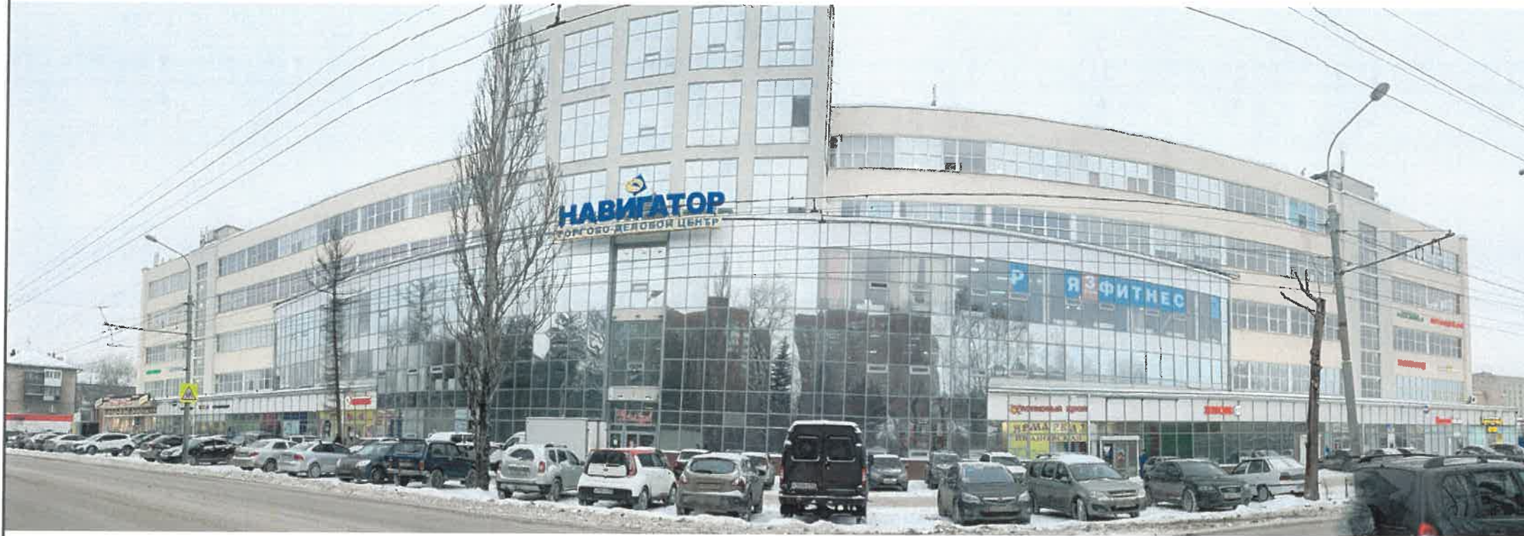
Существующее состояние главного фасада
