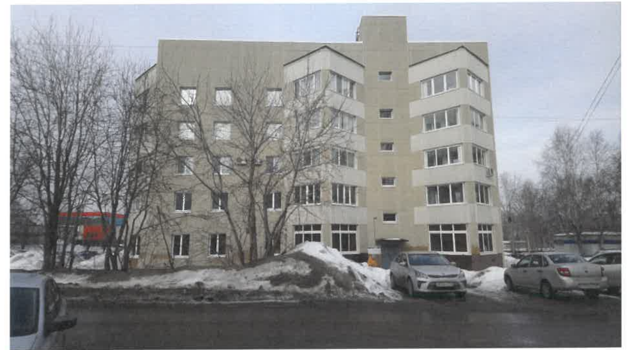
Существующее состояние бокового фасада (фотофиксация).
