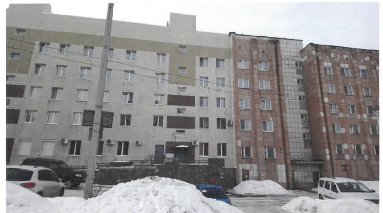
Существующее состояние дворового фасада (фотофиксация).
