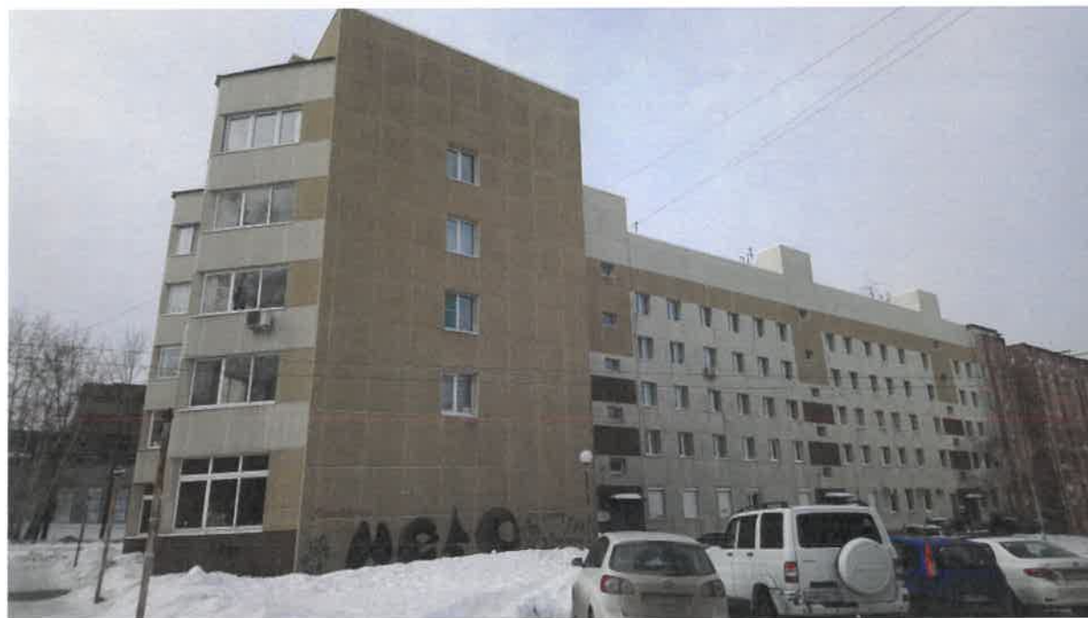
Существующее состояние дворового фасада (фотофиксация).
