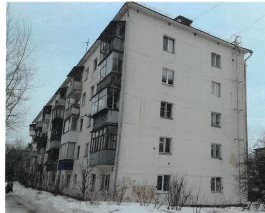
Существующее состояние бокового фасада (фотофиксация).
