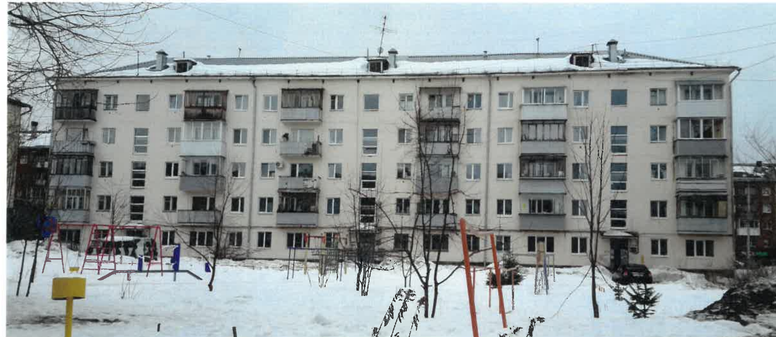
Существующее состояние дворового фасада (фотофиксация).
