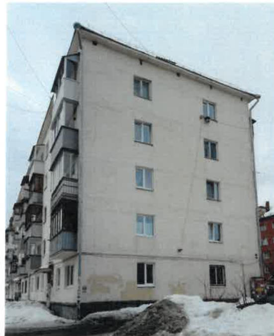
Существующее состояние дворового фасада (фотофиксация).
