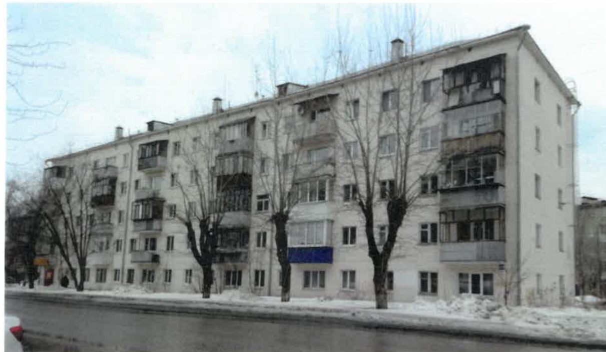
Существующее состояние главного фасада (фотофиксация).
