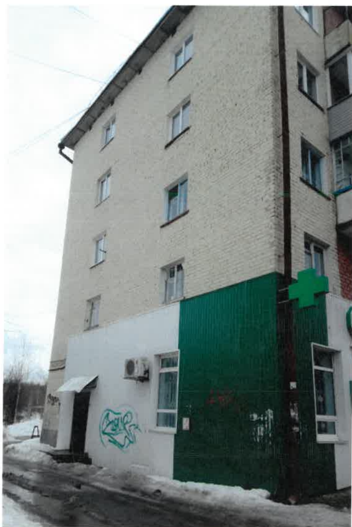
Существующее состояние бокового фасада (фотофиксация).
