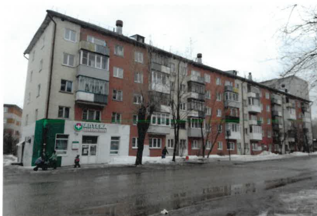
Существующее состояние главного фасада (фотофиксация).
