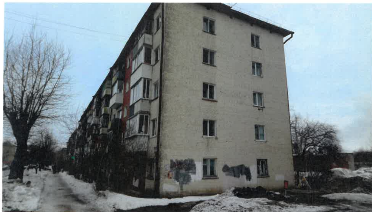
Существующее состояние бокового фасада (фотофиксация).
