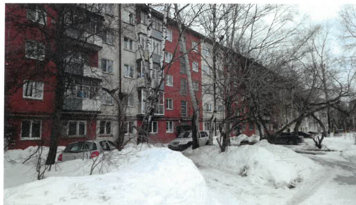
Существующее состояние дворового фасада (фотофиксация).
