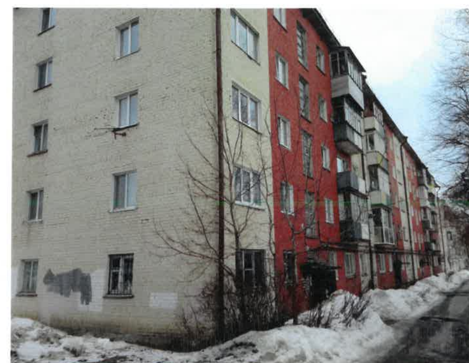
Существующее состояние дворового фасада (фотофиксация).
