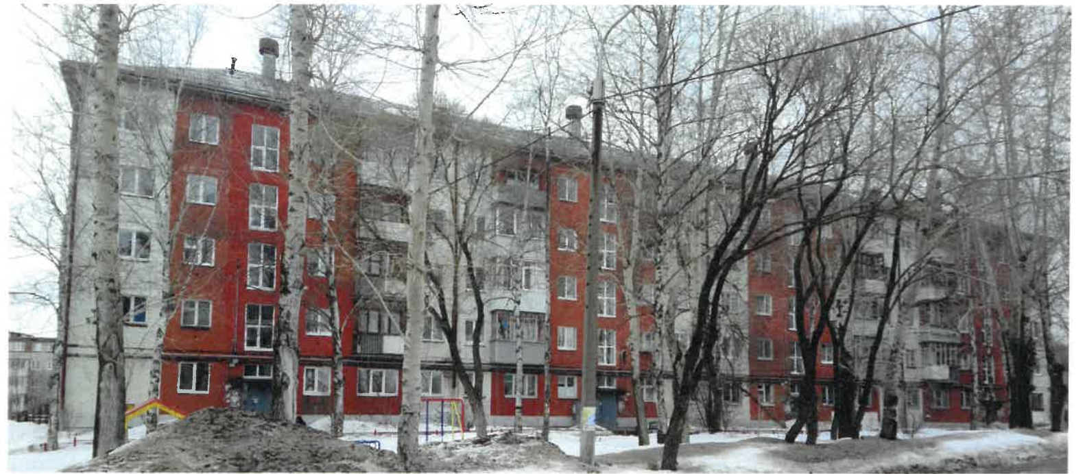
Существующее состояние дворового фасада (фотофиксация).
