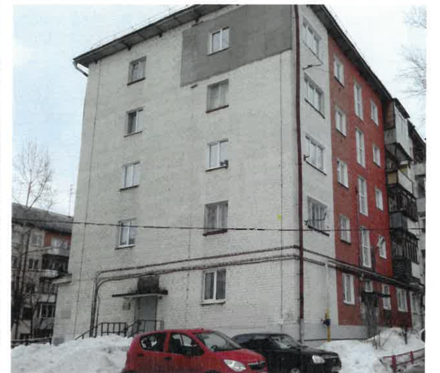
Существующее состояние бокового фасада (фотофиксация).
