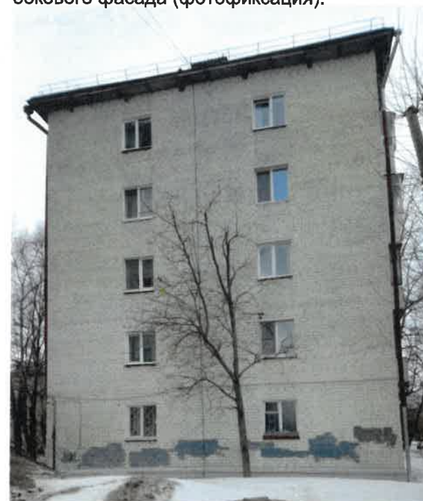
Существующее состояние бокового фасада (фотофиксация).
