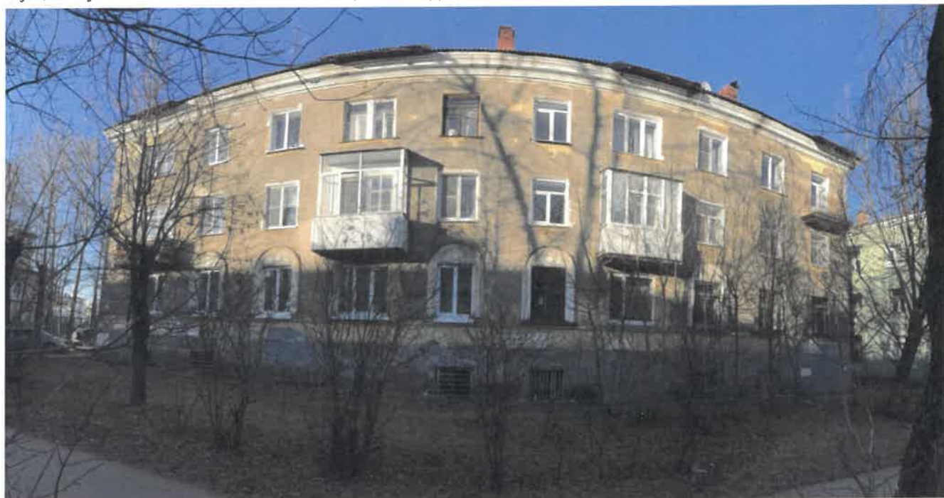
Существующее состояние главного фасада (фотофиксация)
