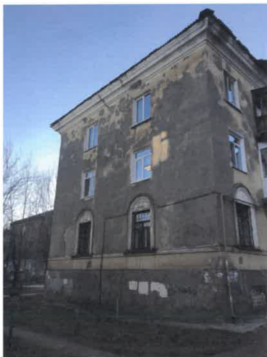
Существующее состояние бокового фасада (фотофиксация)
