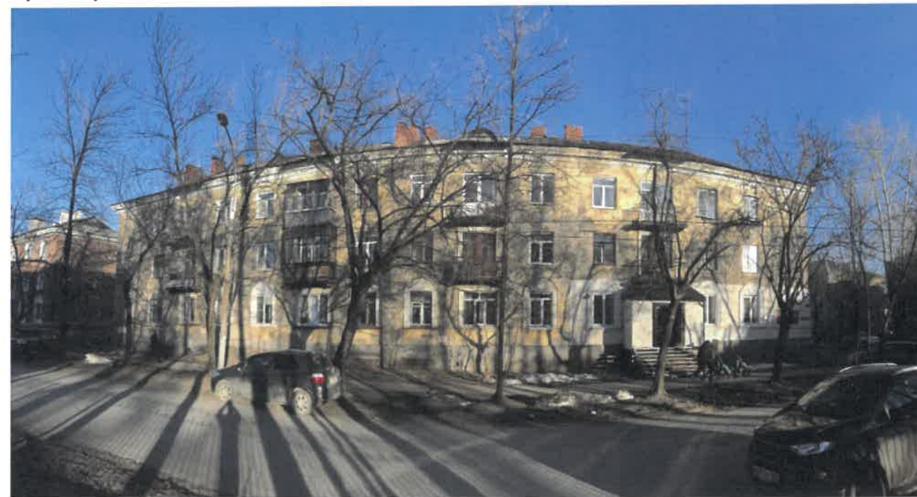
Существующее состояние главного фасада (фотофиксация)
