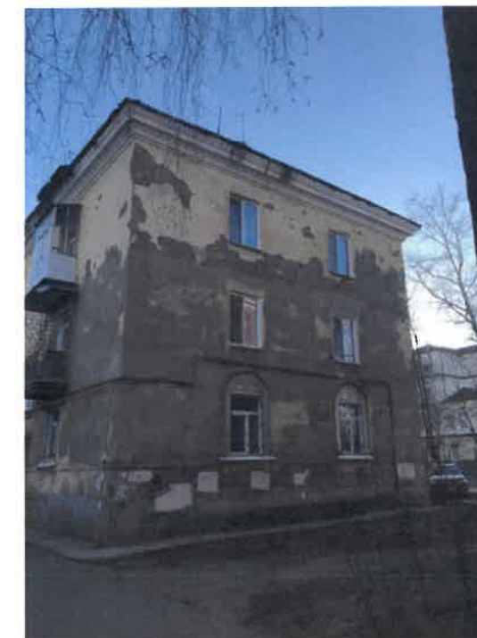
Существующее состояние бокового фасада (фотофиксация)
