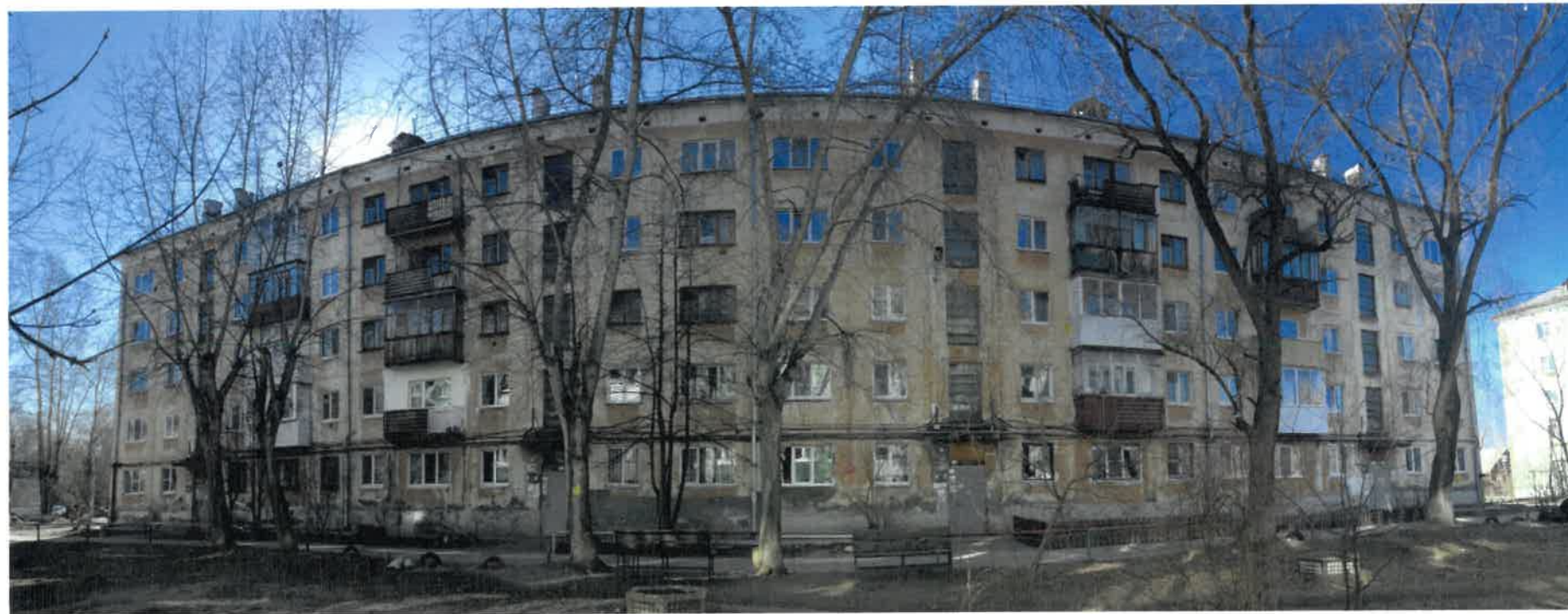
Существующее состояние дворового фасада (фотофиксация).
