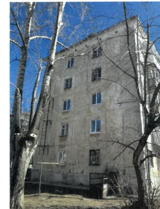
Существующее состояние бокового фасада (фотофиксация).
