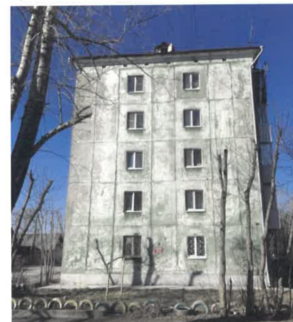
Существующее состояние бокового фасада (фотофиксация).
