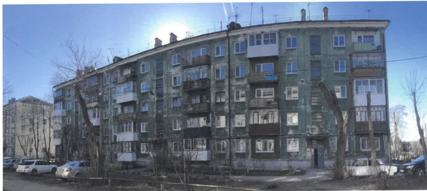
Существующее состояние дворового фасада (фотофиксация).
