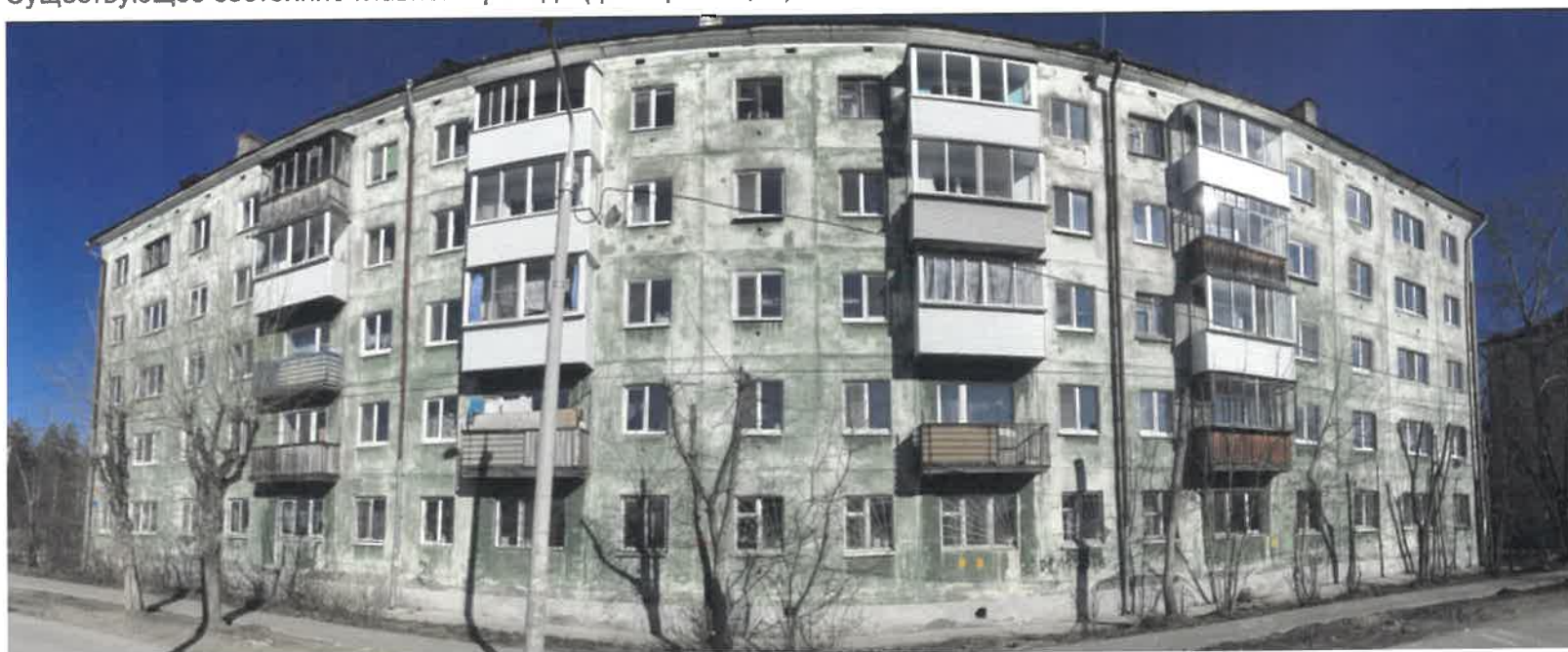
Существующее состояние главного фасада (фотофиксация).
