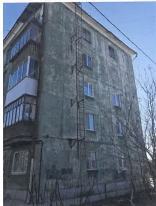
Существующее состояние бокового фасада (фотофиксация).
