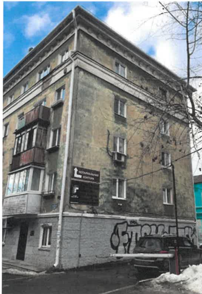
Существующее состояние бокового фасада (фотофиксация)
