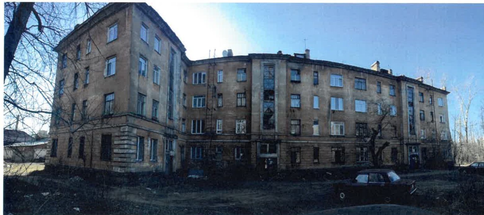
Существующее состояние дворового фасада (фотофиксация)
