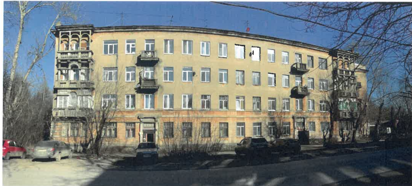
Существующее состояние главного фасада (фотофиксация)
