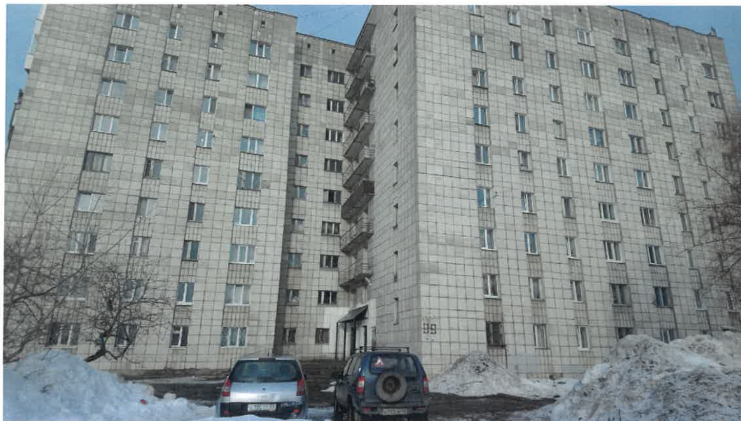
Существующее состояние главного фасада (фотофиксация).
