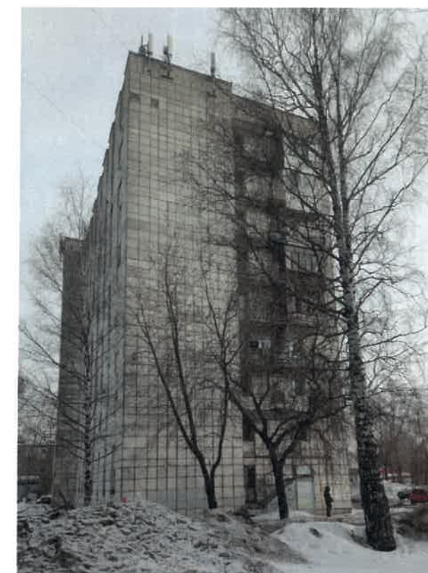
Существующее состояние бокового фасада (фотофиксация).
