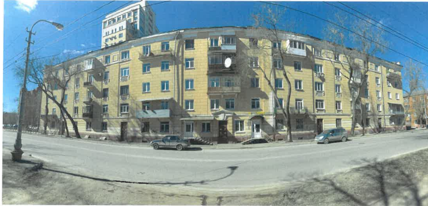
Существующее состояние главного фасада (фотофиксация)
