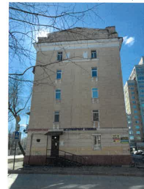
Существующее состояние бокового фасада (фотофиксация)
