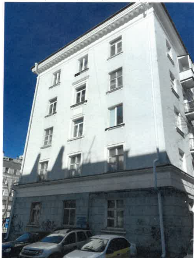
Существующее состояние бокового фасада (фотофиксация)
