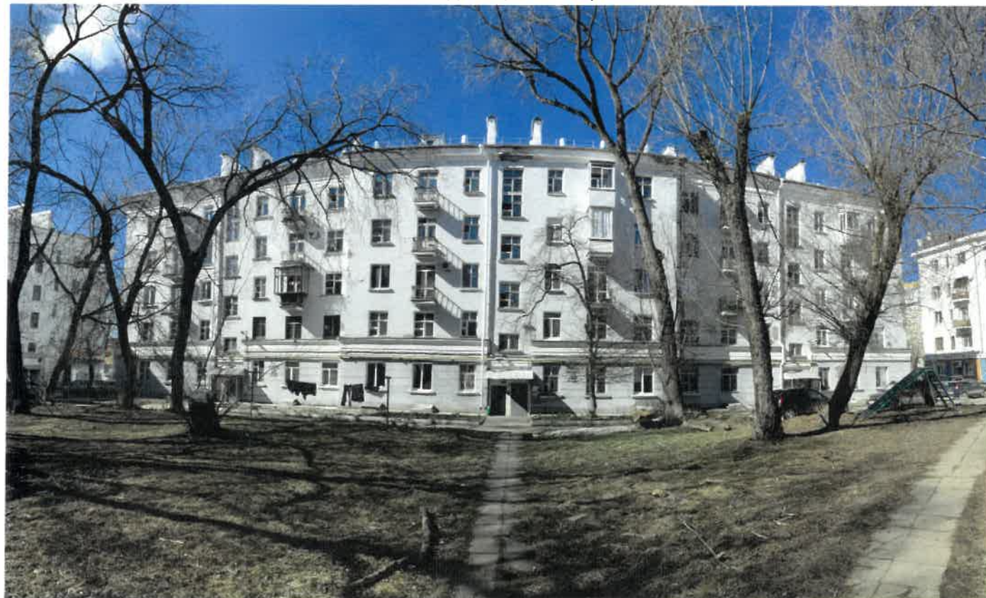
Существующее состояние дворового фасада (фотофиксация)
