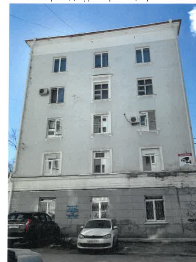
Существующее состояние бокового фасада (фотофиксация)
