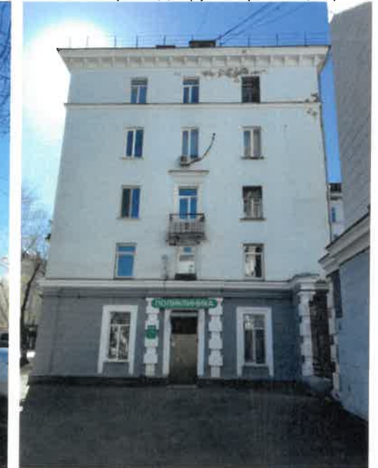
Существующее состояние бокового фасада (фотофиксация)
