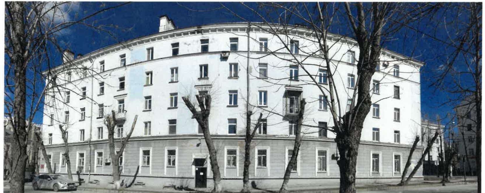
Существующее состояние главного фасада (фотофиксация)
