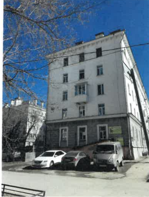
Существующее состояние бокового фасада (фотофиксация)
