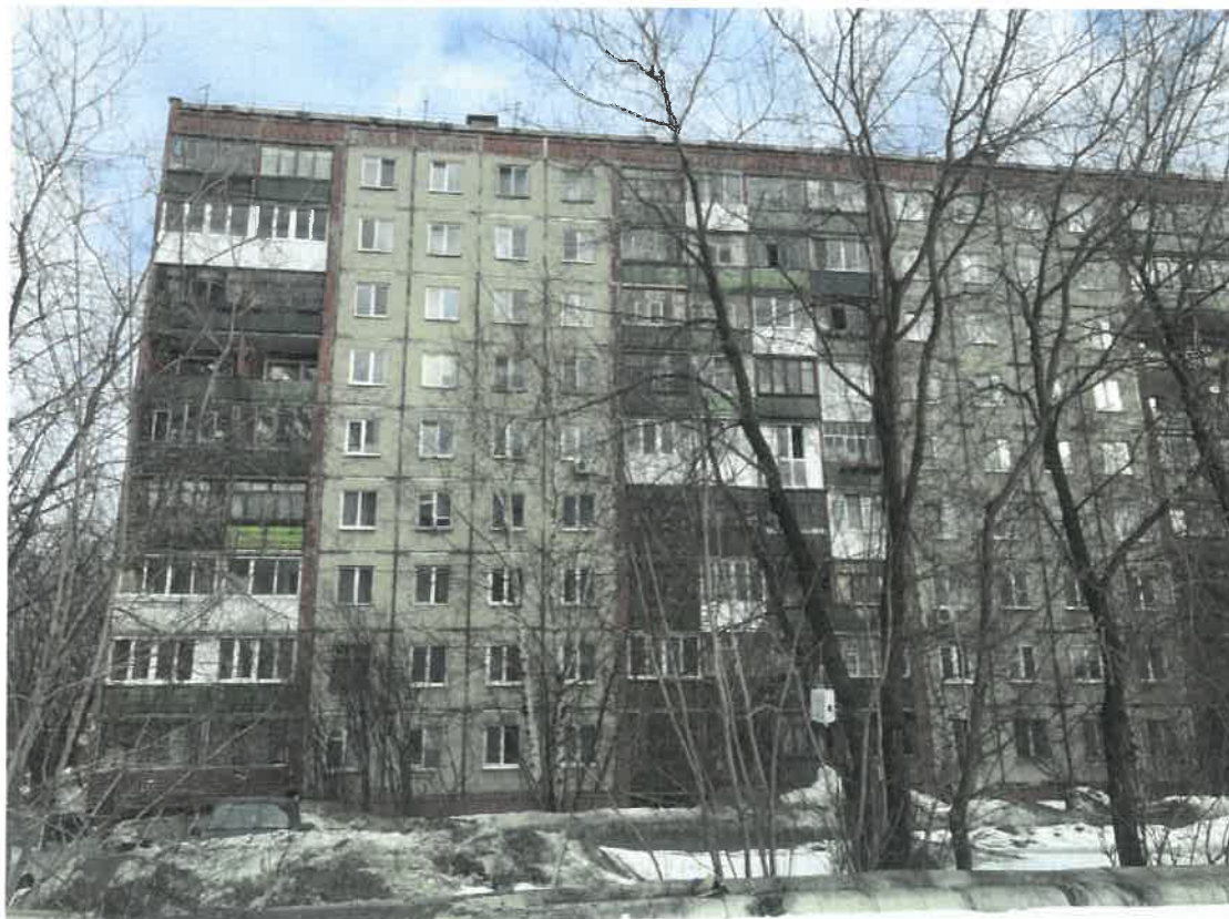
Существующее состояние главного фасада (фотофиксация).
