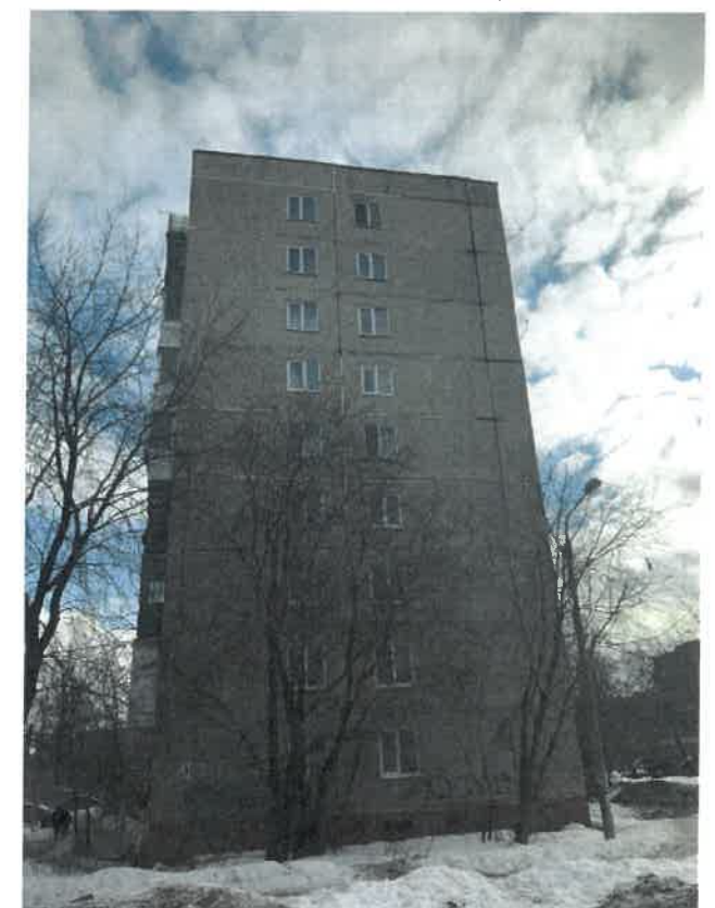
Существующее состояние бокового фасада (фотофиксация).
