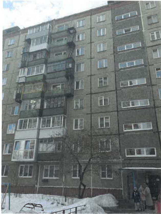
Существующее состояние дворового фасада (фотофиксация).
