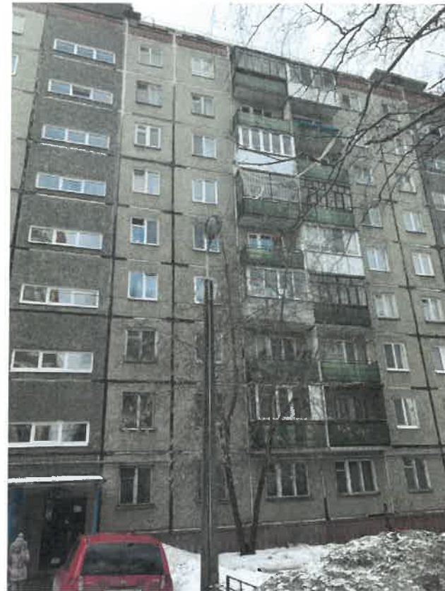
Существующее состояние дворового фасада (фотофиксация).
