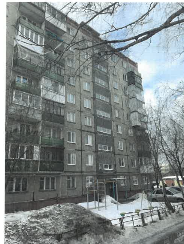
Существующее состояние дворового фасада (фотофиксация).
