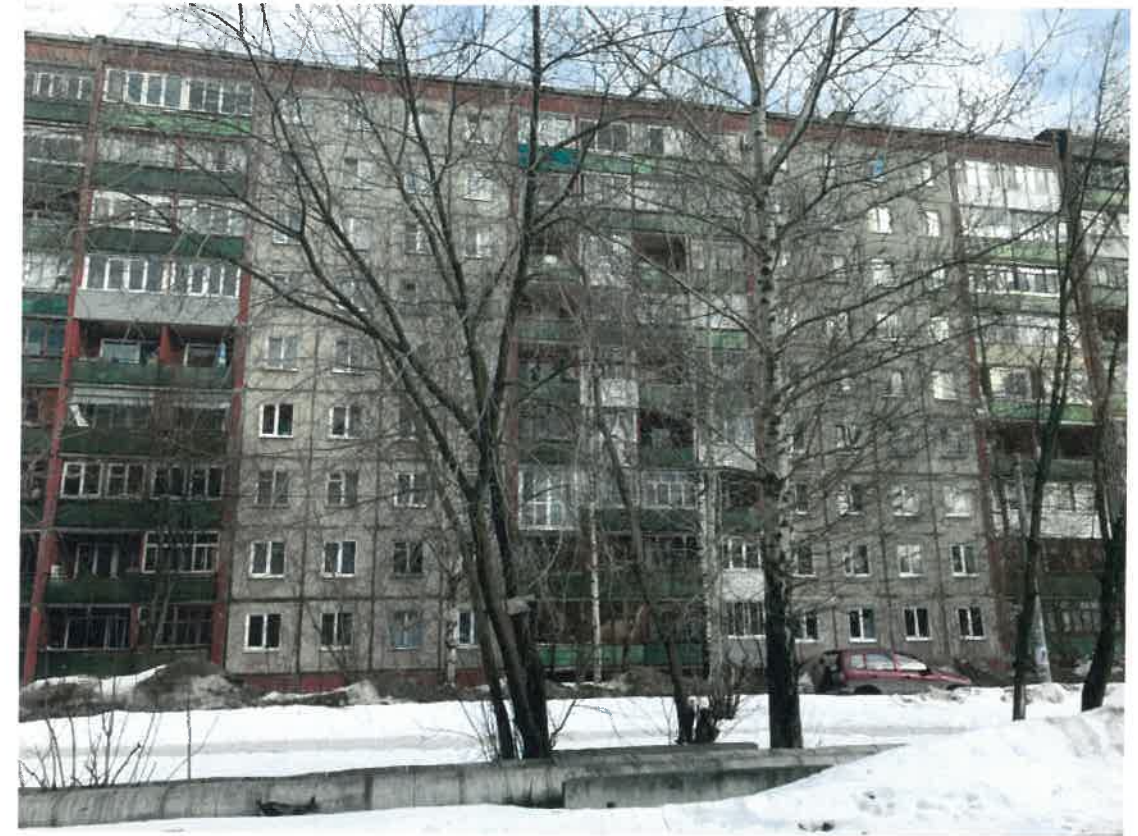
Существующее состояние главного фасада (фотофиксация).
