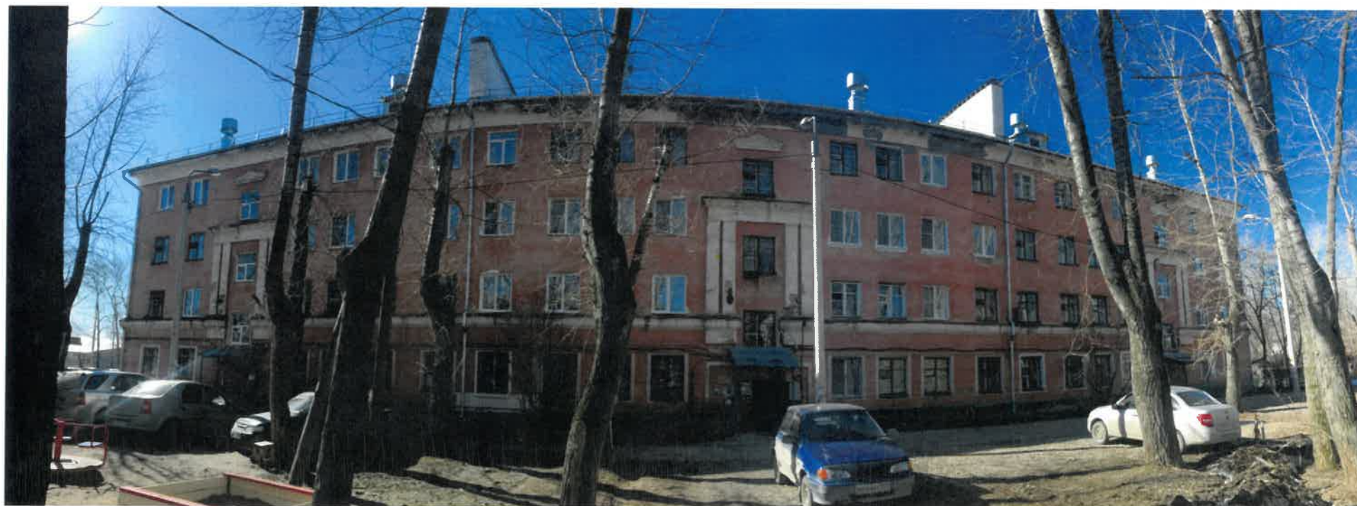
Существующее состояние дворового фасада (фотофиксация).
