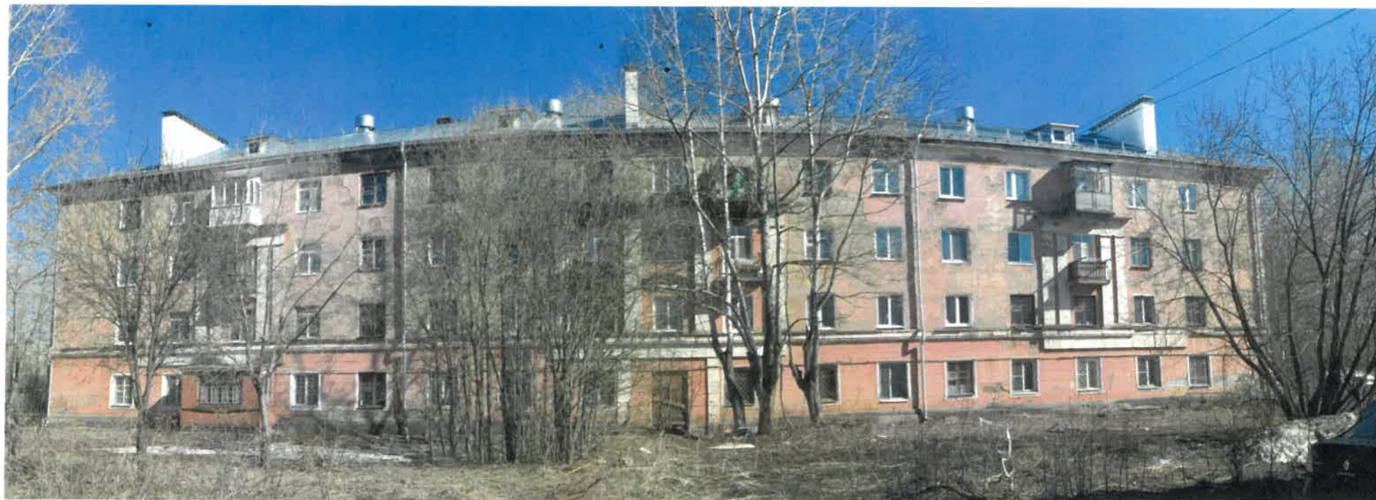
Существующее состояние главного фасада (фотофиксация).
