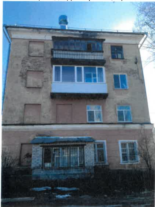
Существующее состояние бокового фасада (фотофиксация).
