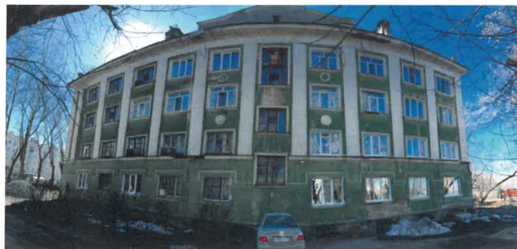
Существующее состояние дворового фасада (фотофиксация)
