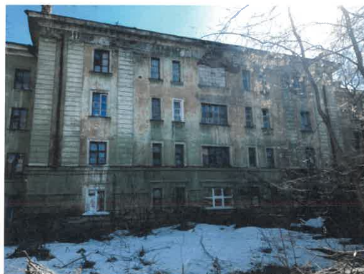
Существующее состояние дворового фасада (фотофиксация)
