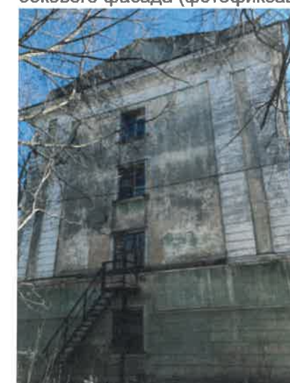
Существующее состояние бокового фасада (фотофиксация)
