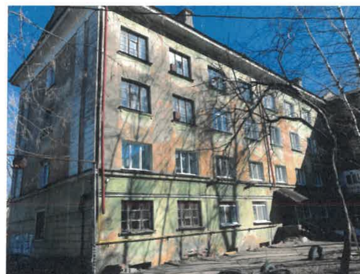
Существующее состояние дворового фасада (фотофиксация)
