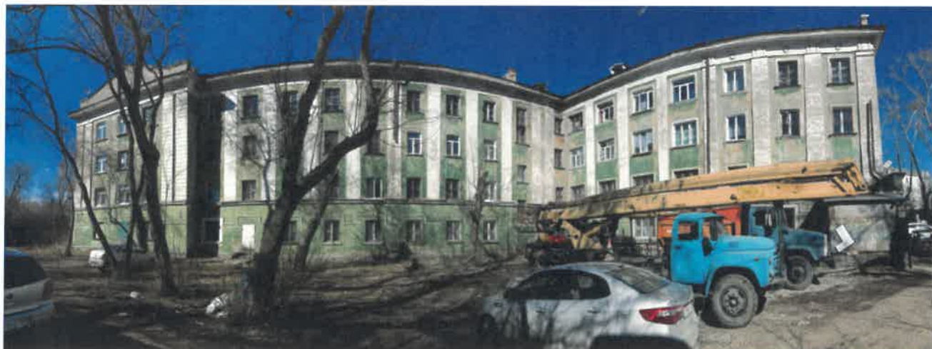
Существующее состояние главного фасада (фотофиксация)
