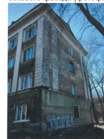
Существующее состояние бокового фасада (фотофиксация)
