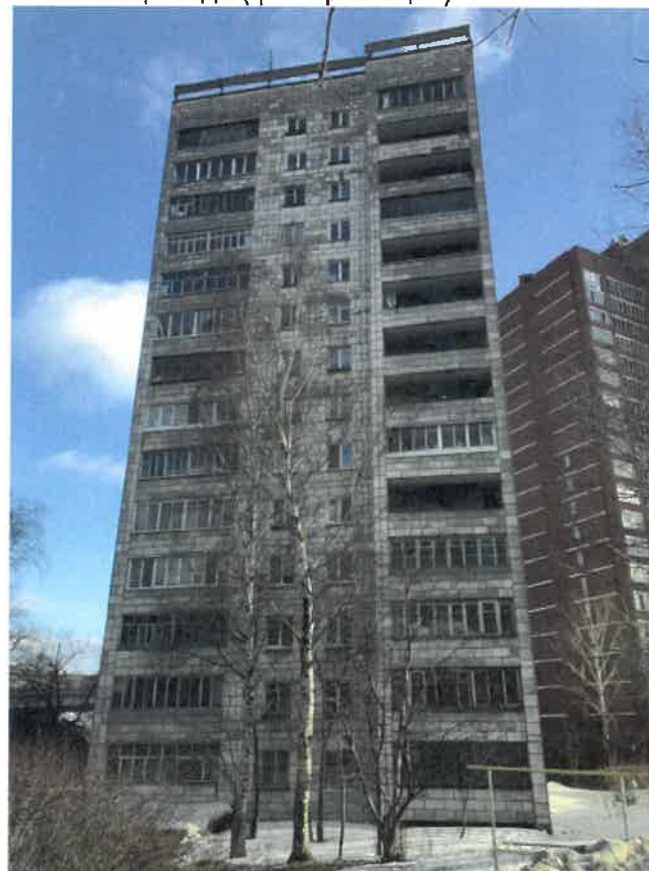
Существующее состояние бокового фасада (фотофиксация).
