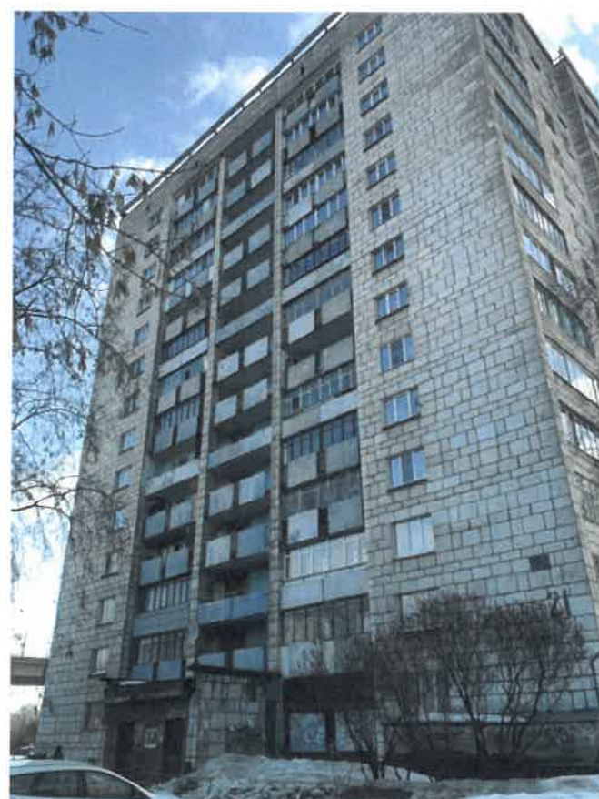
Существующее состояние дворового фасада (фотофиксация).
