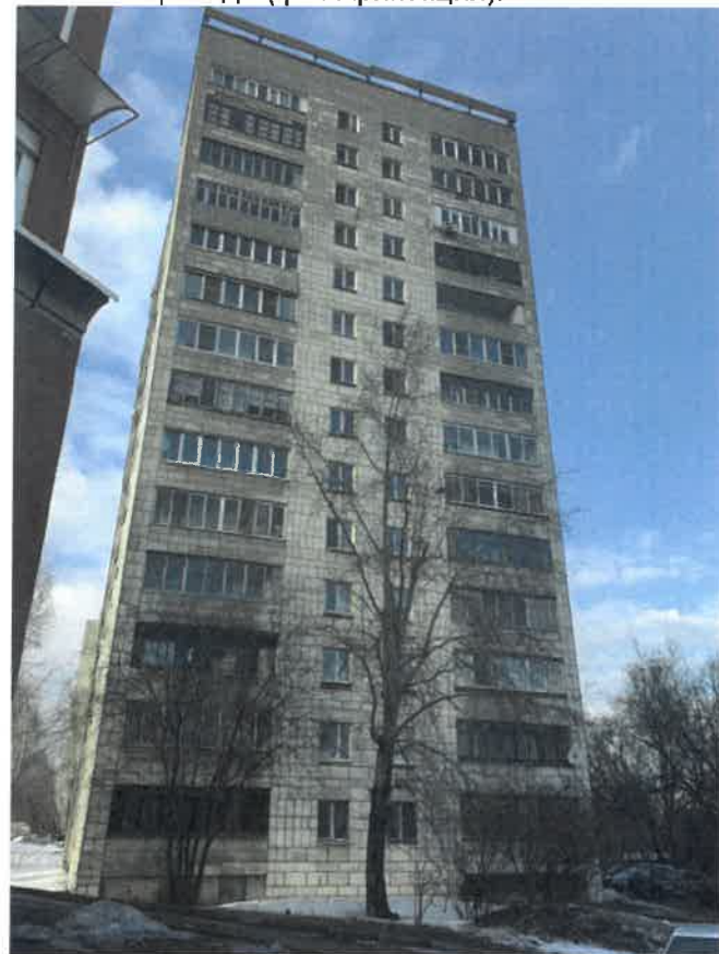
Существующее состояние бокового фасада (фотофиксация).
