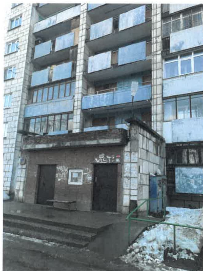
Существующее состояние дворового фасада (фотофиксация).
