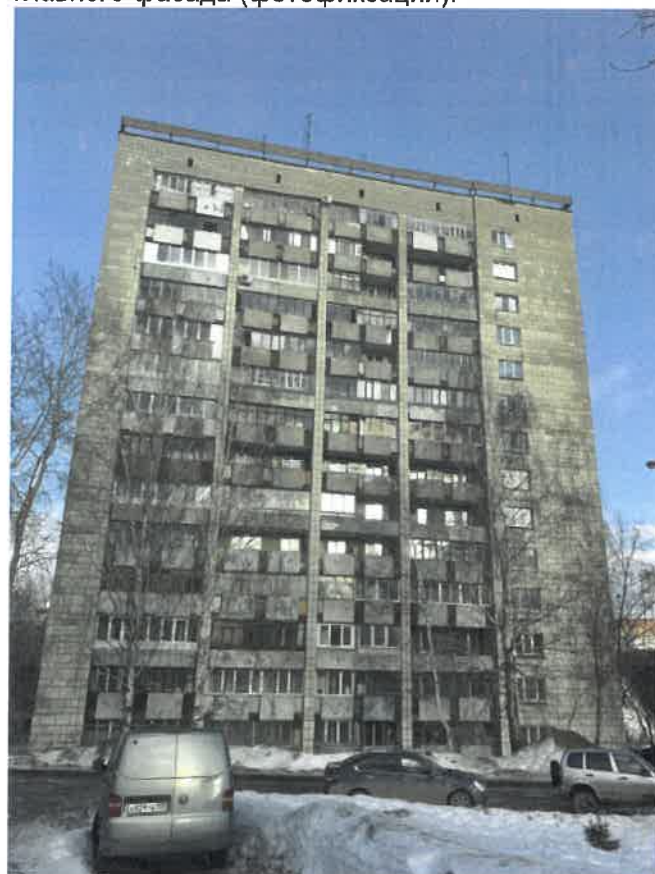
Существующее состояние главного фасада (фотофиксация).
