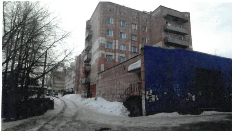
Существующее состояние бокового фасада (фотофиксация).
