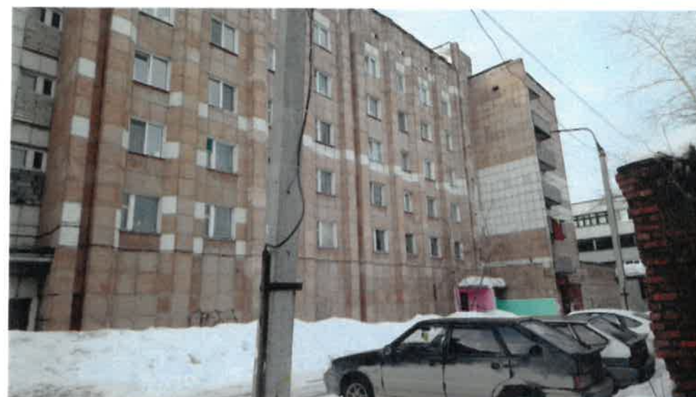
Существующее состояние дворового фасада (фотофиксация).
