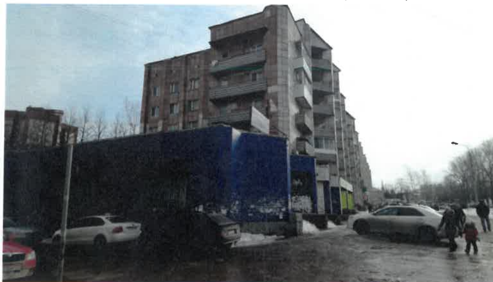
Существующее состояние бокового фасада (фотофиксация).
