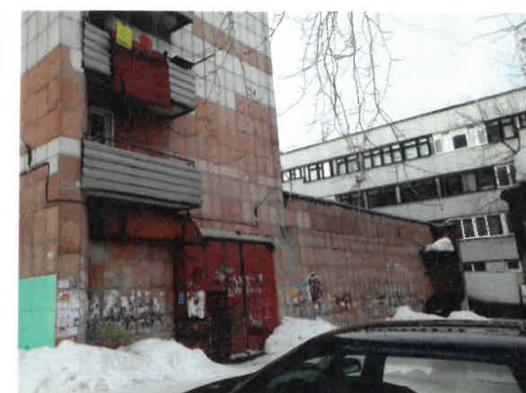
Существующее состояние дворового фасада (фотофиксация).
