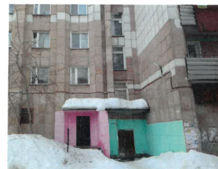
Существующее состояние дворового фасада (фотофиксация).
