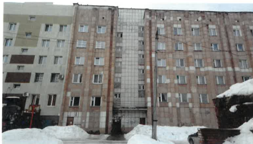
Существующее состояние дворового фасада (фотофиксация).
