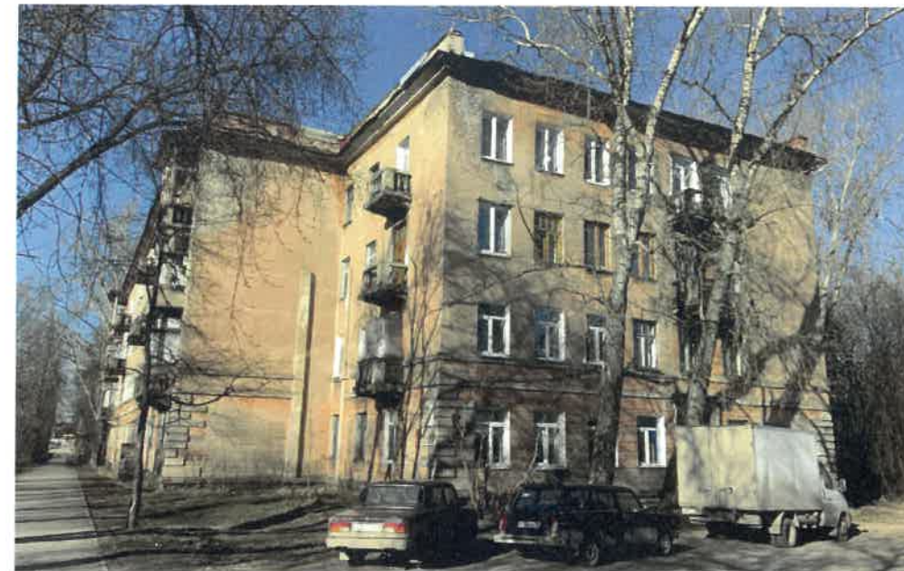
Существующее состояние бокового фасада (фотофиксация)
