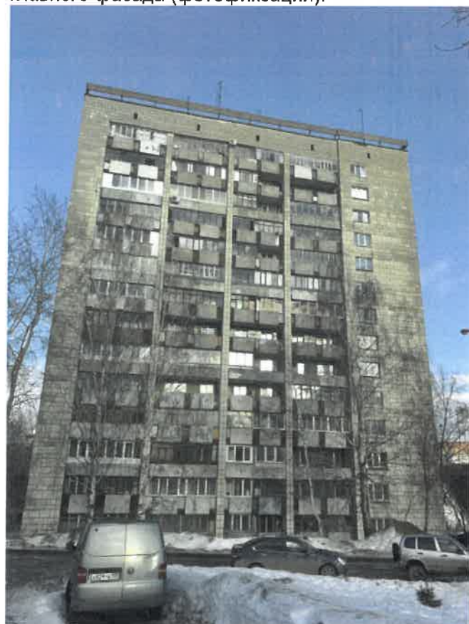
Существующее состояние главного фасада (фотофиксация).
