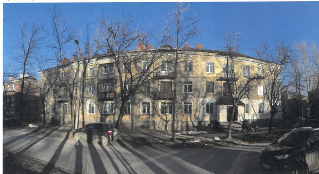
Существующее состояние главного фасада (фотофиксация)
