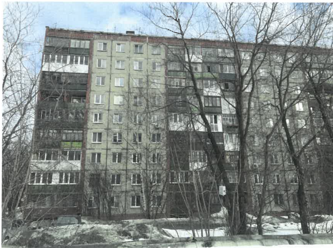
Существующее состояние главного фасада (фотофиксация).
