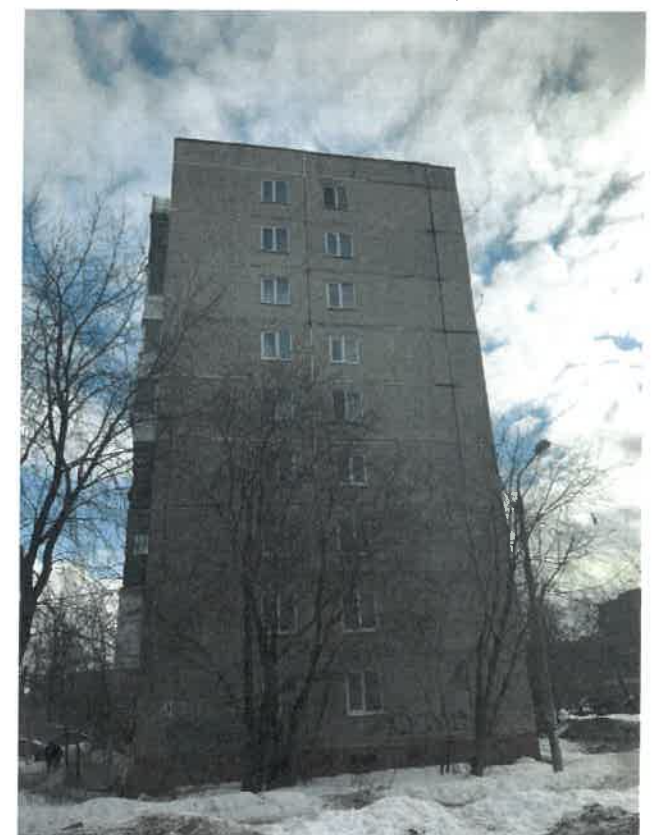
Существующее состояние бокового фасада (фотофиксация).
