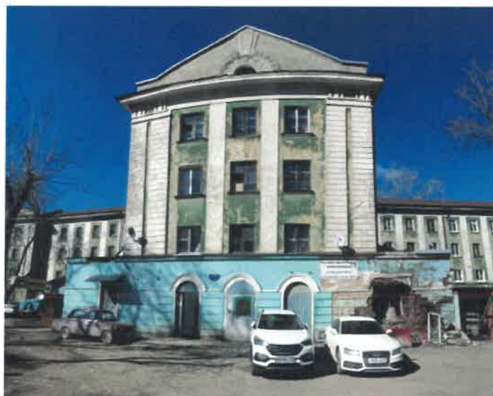
Существующее состояние главного фасада (фотофиксация)
