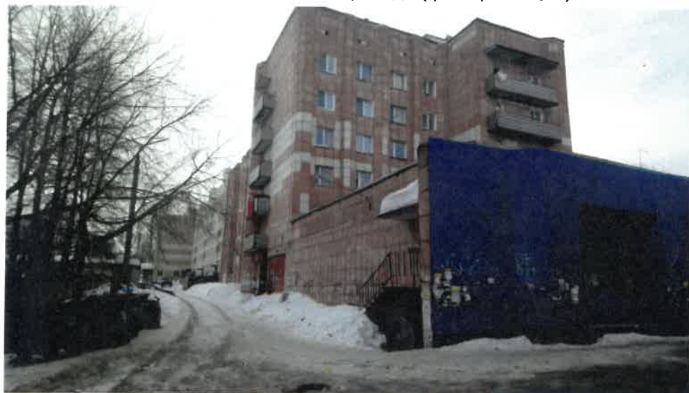
Существующее состояние бокового фасада (фотофиксация).
