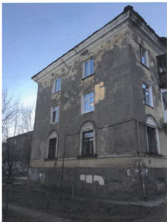
Существующее состояние бокового фасада (фотофиксация)
