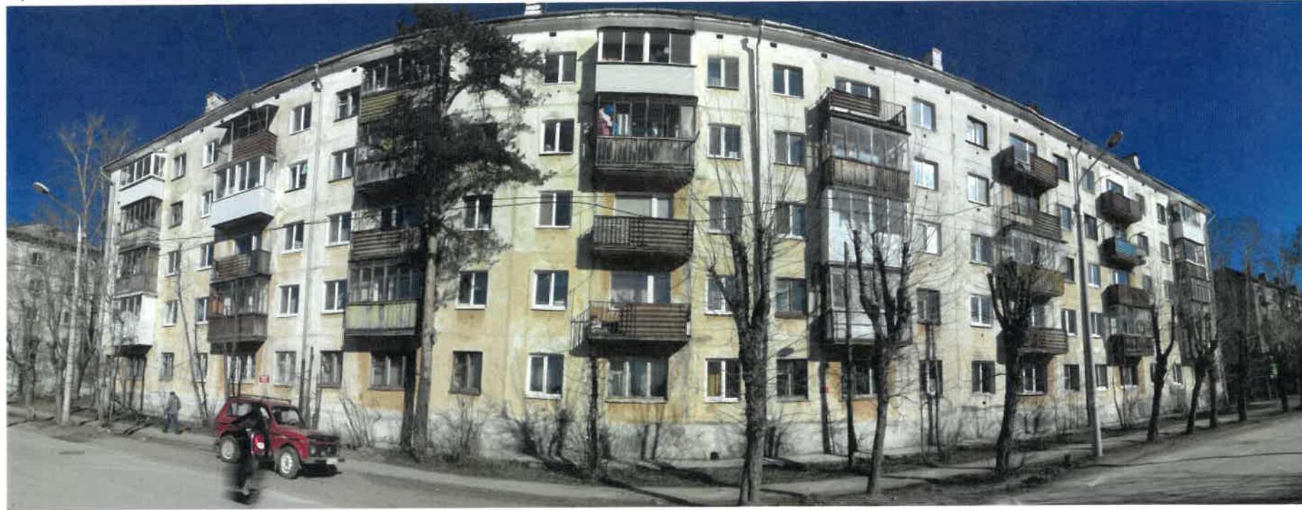
Существующее состояние главного фасада (фотофиксация).
