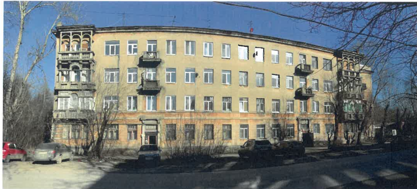
Существующее состояние главного фасада (фотофиксация)
