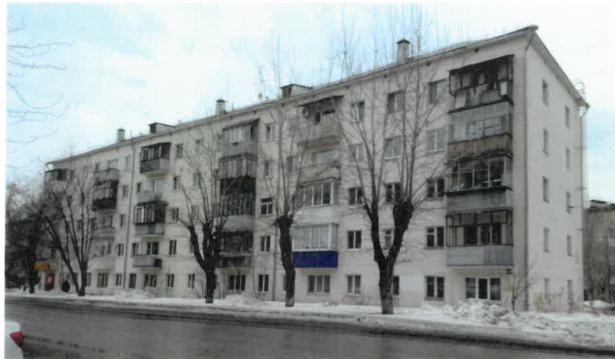
Существующее состояние главного фасада (фотофиксация).
