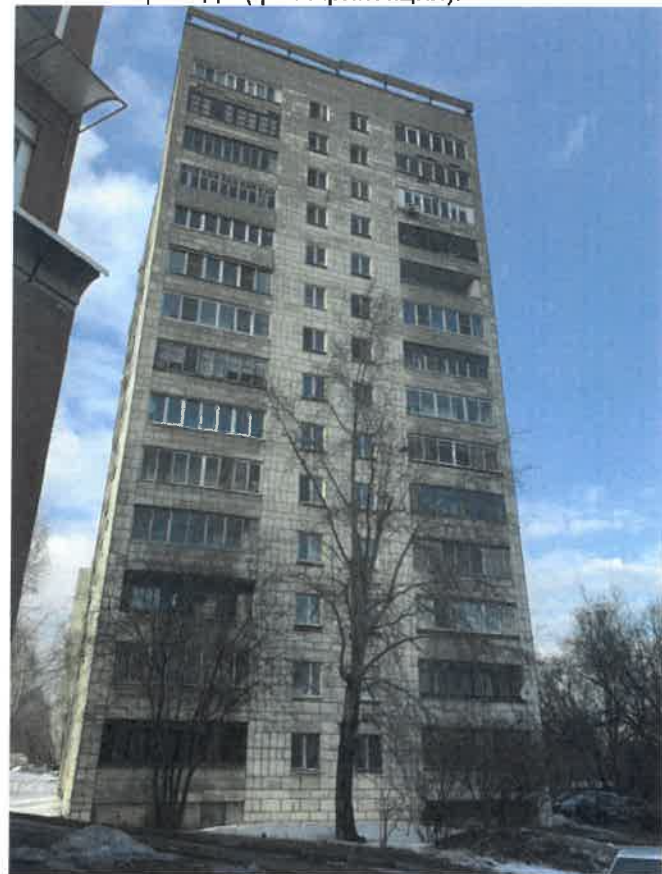
Существующее состояние бокового фасада (фотофиксация).
