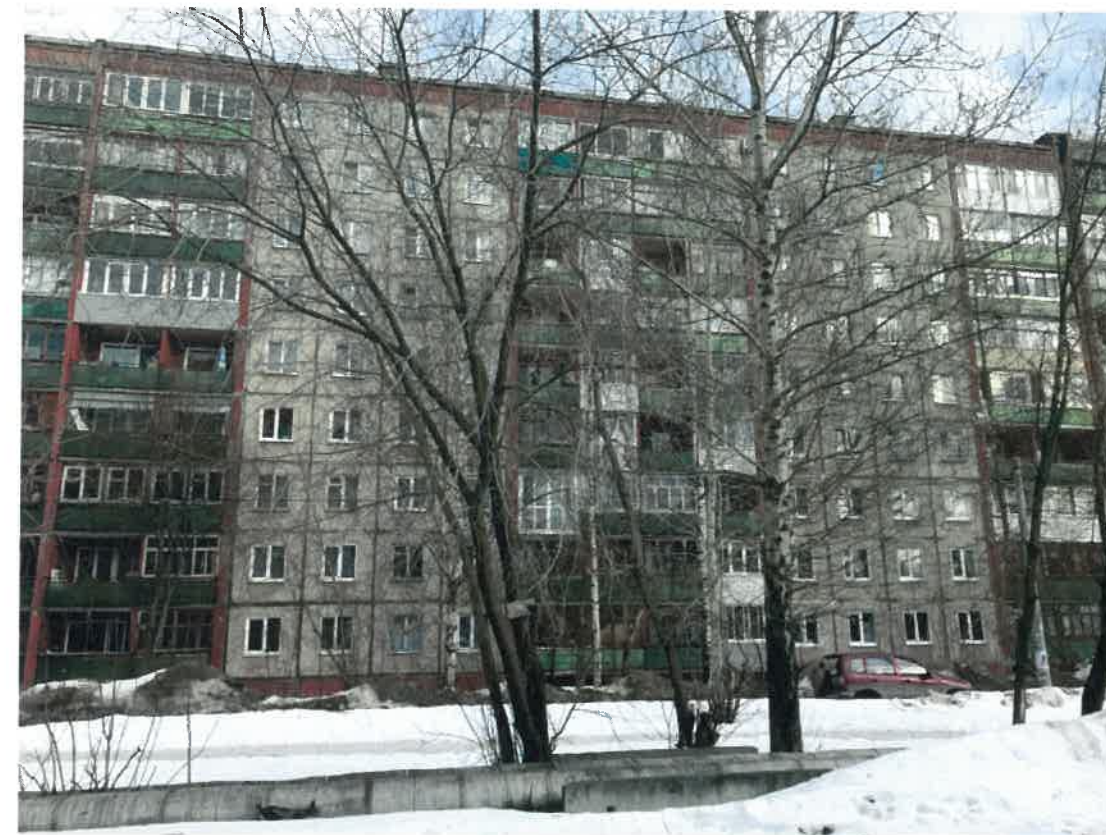
Существующее состояние главного фасада (фотофиксация).
