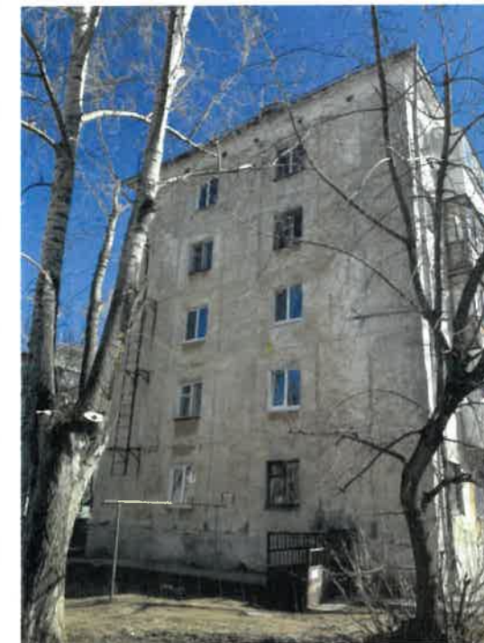
Существующее состояние бокового фасада (фотофиксация).
