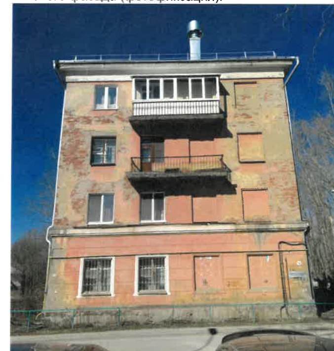
Существующее состояние бокового фасада (фотофиксация).
