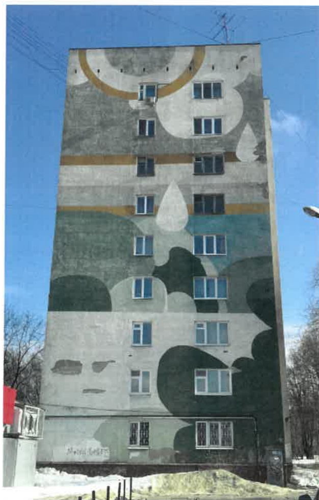
Существующее состояние бокового фасада (фотофиксация).
