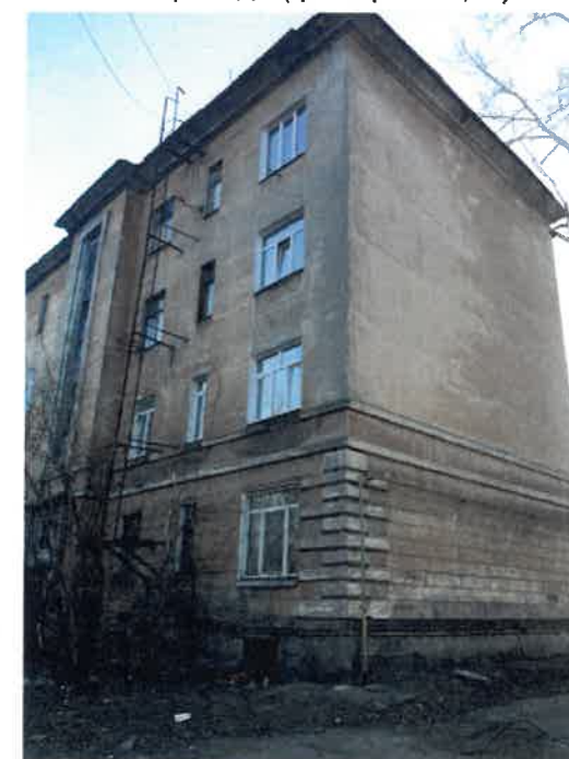
Существующее состояние бокового фасада (фотофиксация)
