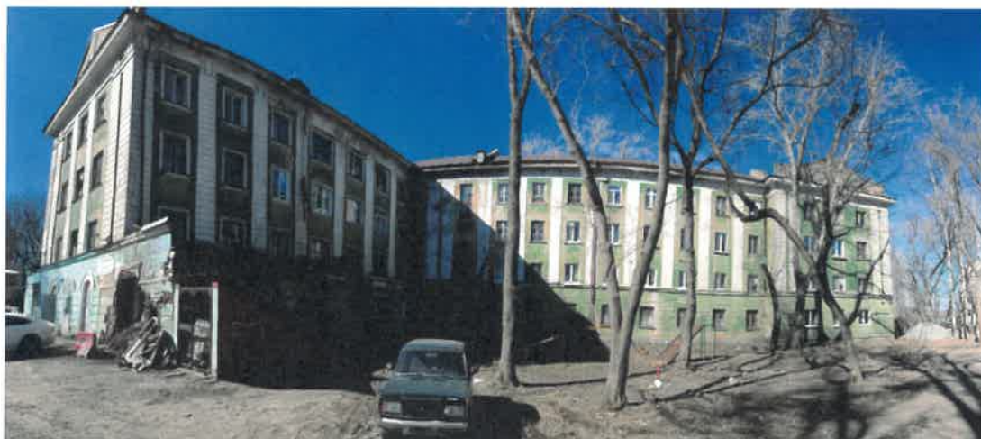
Существующее состояние главного фасада (фотофиксация)
