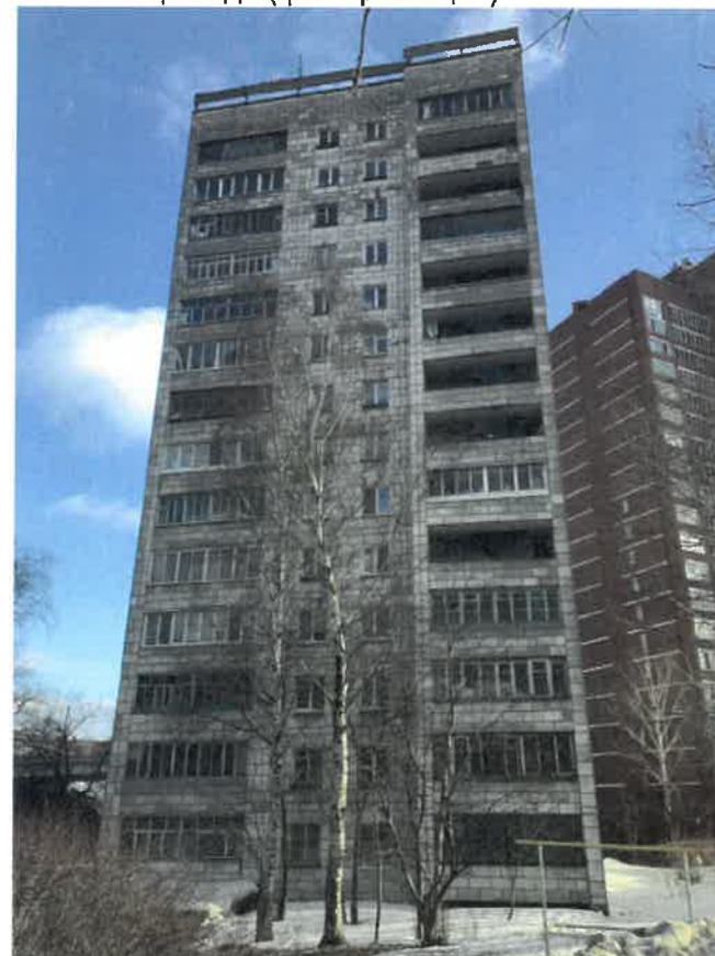
Существующее состояние бокового фасада (фотофиксация).
