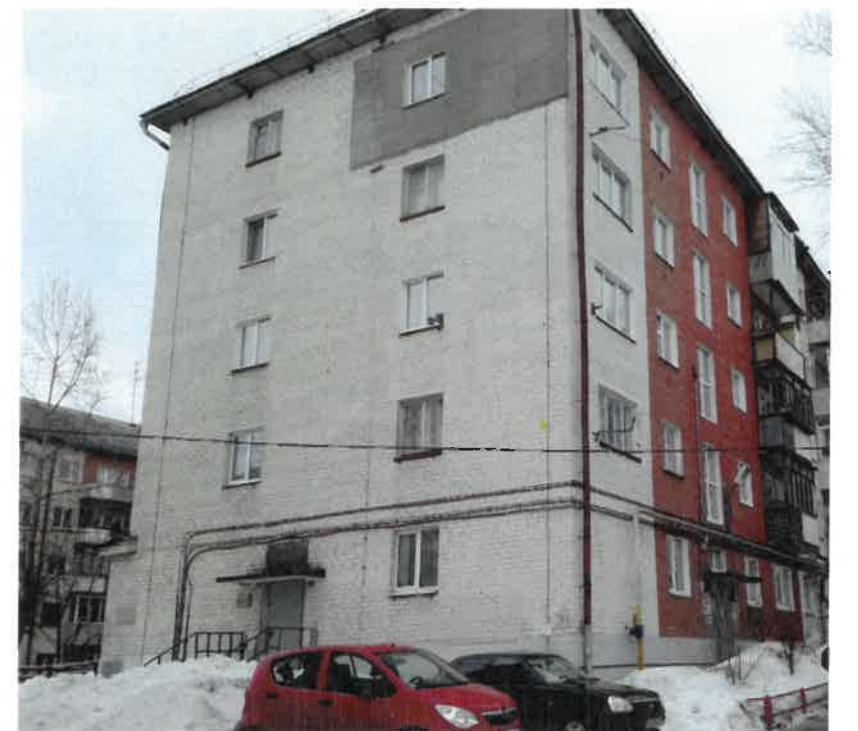
Существующее состояние бокового фасада (фотофиксация).
