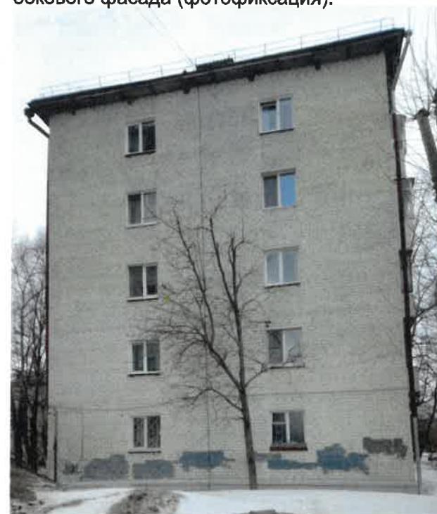
Существующее состояние бокового фасада (фотофиксация).
