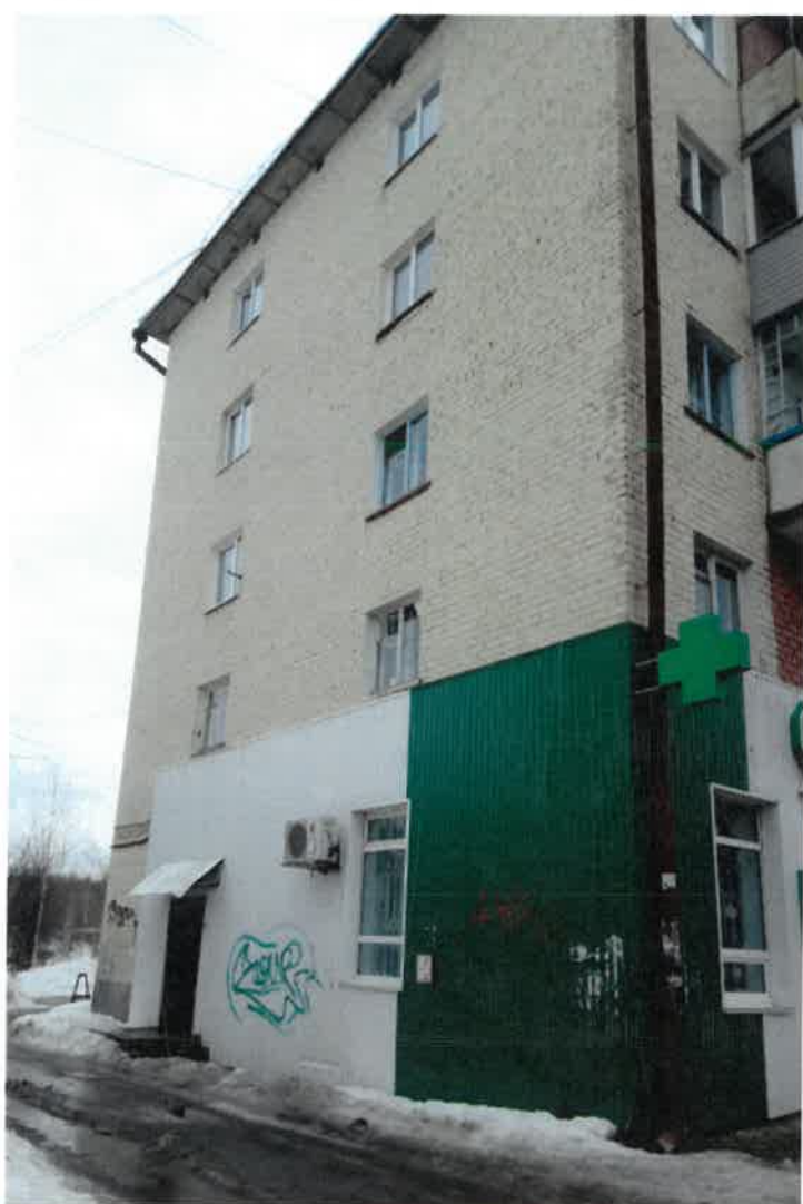
Существующее состояние бокового фасада (фотофиксация).
