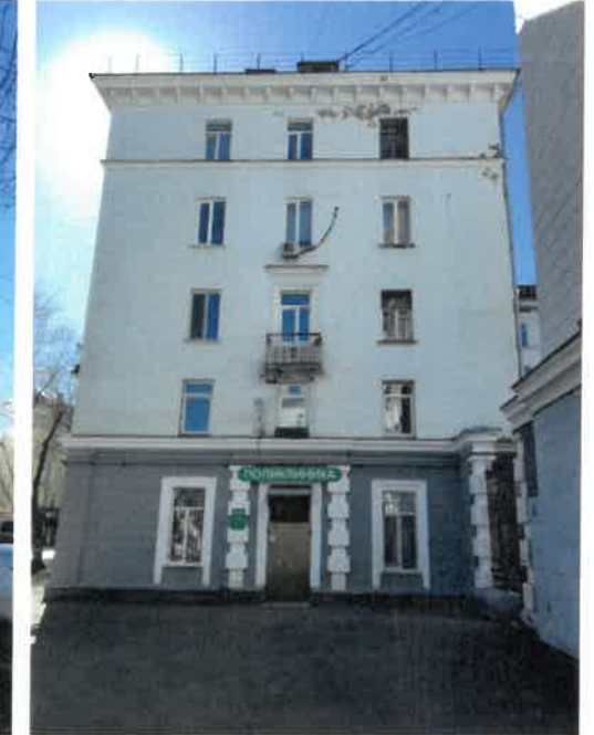
Существующее состояние бокового фасада (фотофиксация)
