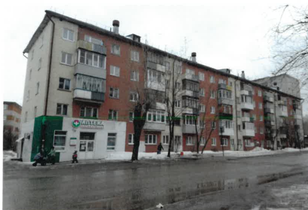
Существующее состояние главного фасада (фотофиксация).
