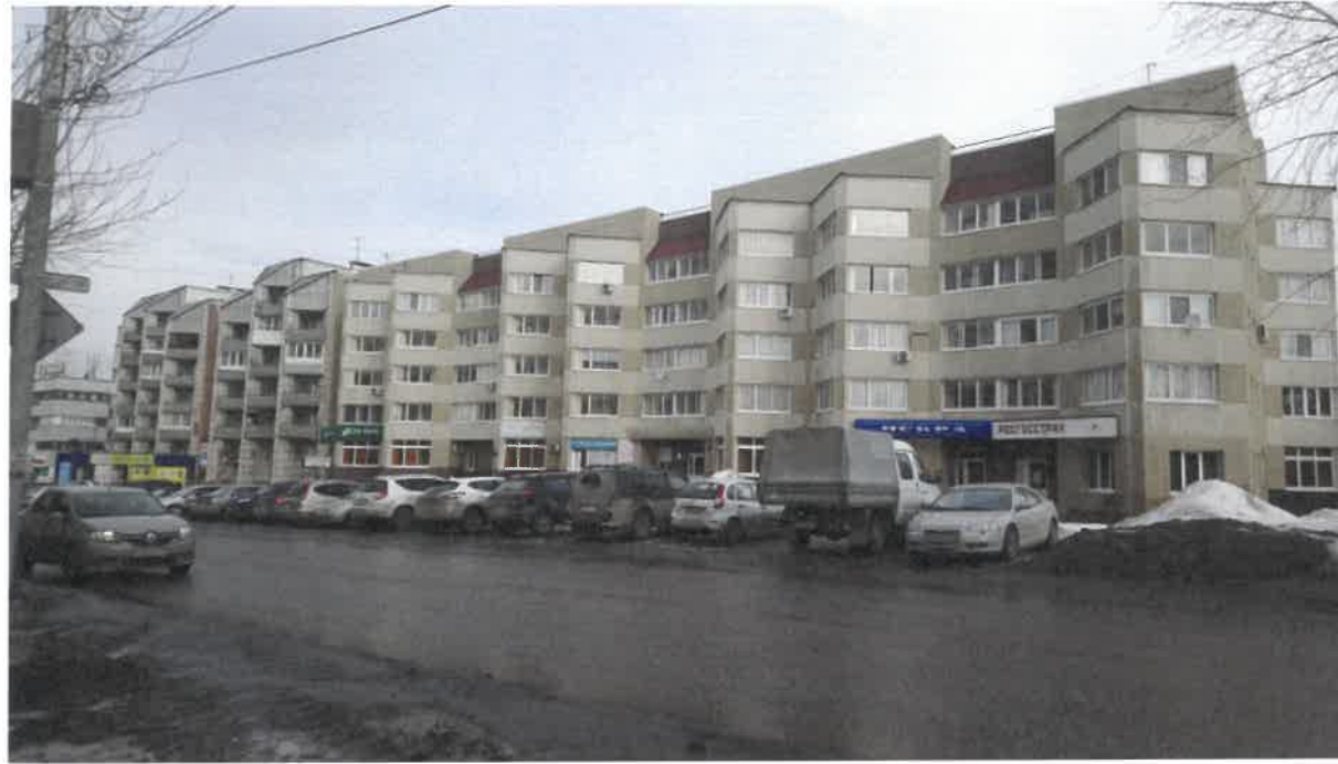
Существующее состояние главного фасада (фотофиксация).
