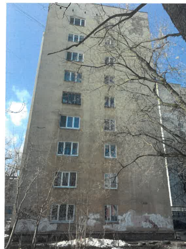
Существующее состояние бокового фасада (фотофиксация).
