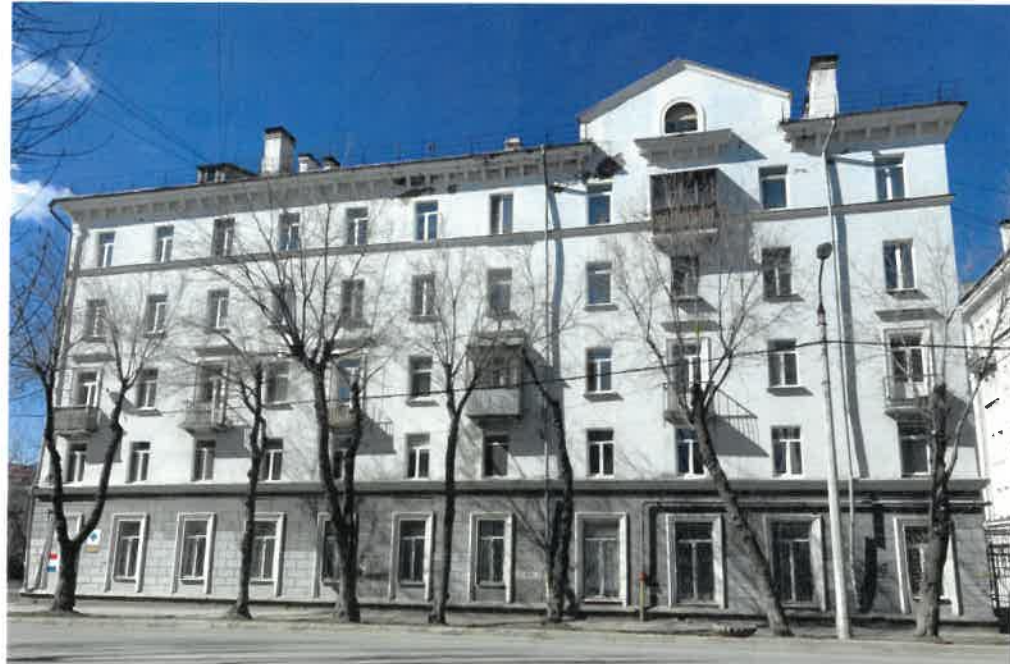
Существующее состояние главного фасада (фотофиксация)
