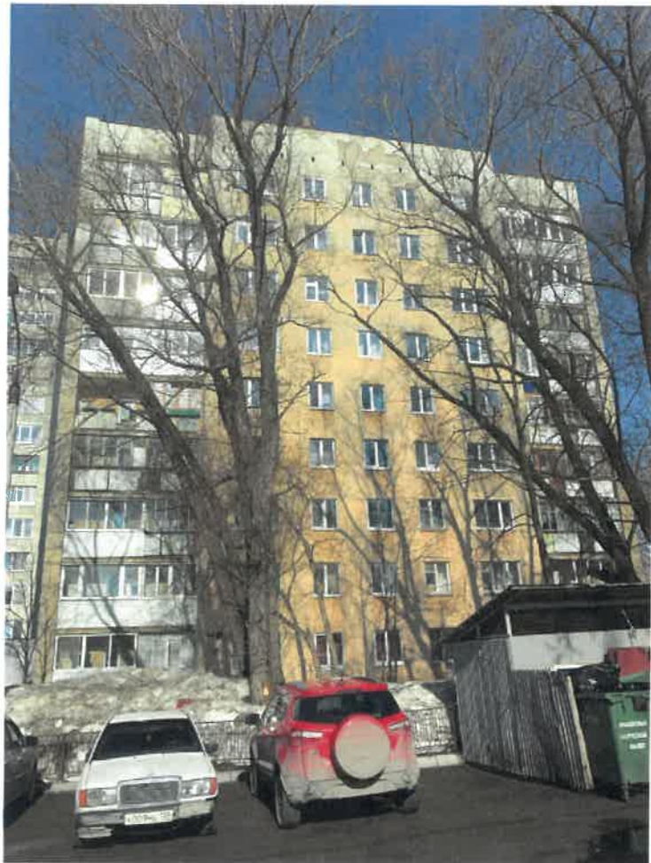
Существующее состояние главного фасада (фотофиксация).
