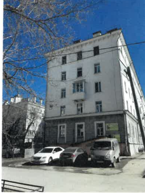
Существующее состояние бокового фасада (фотофиксация)
