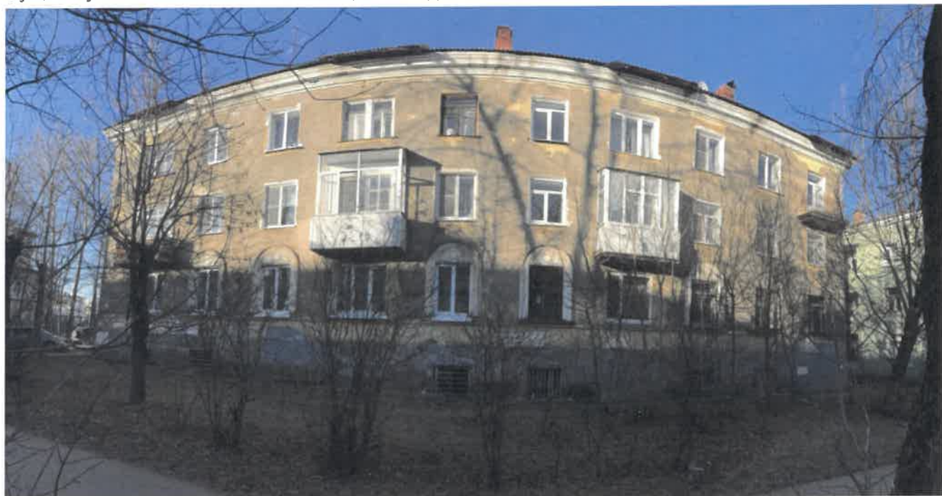
Существующее состояние главного фасада (фотофиксация)
