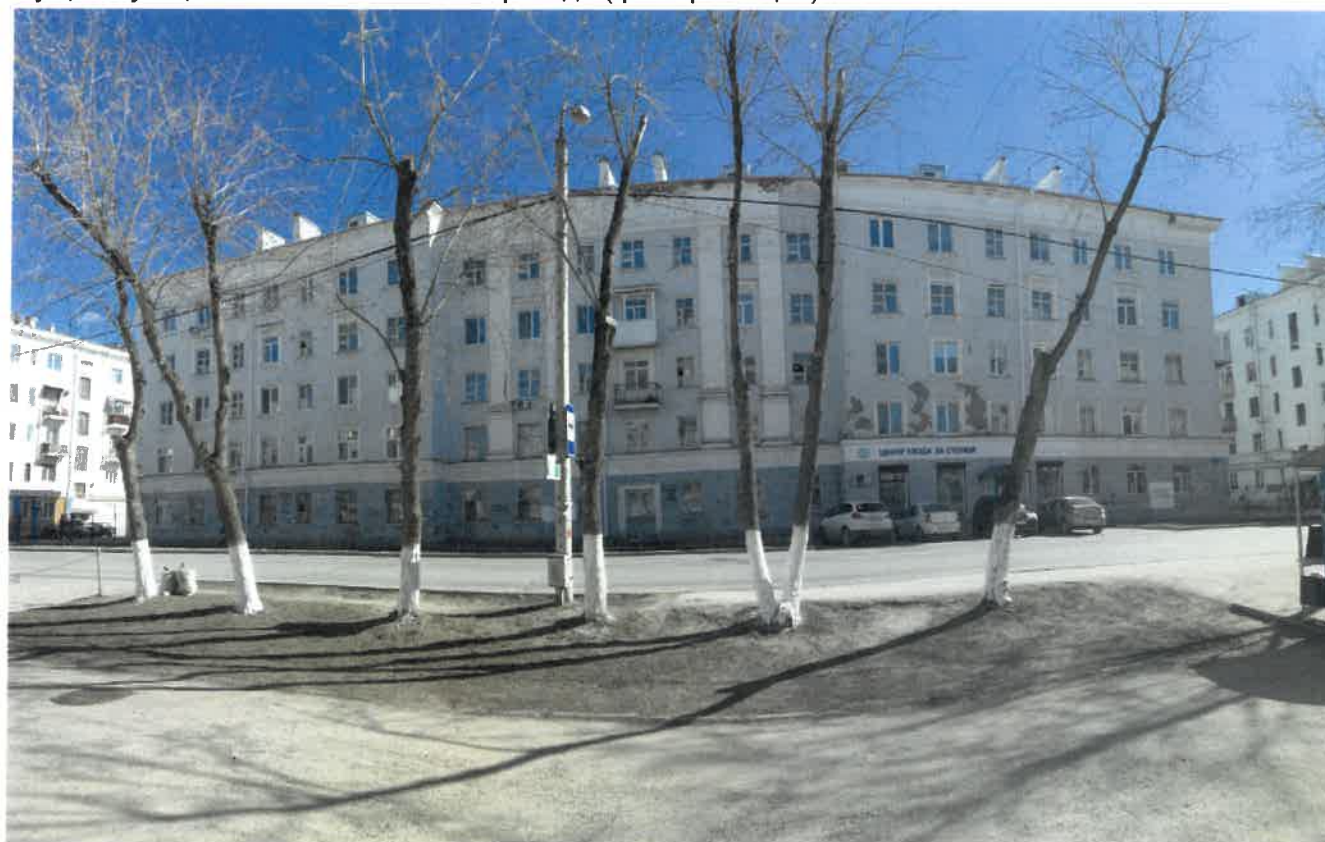
Существующее состояние главного фасада (фотофиксация)
