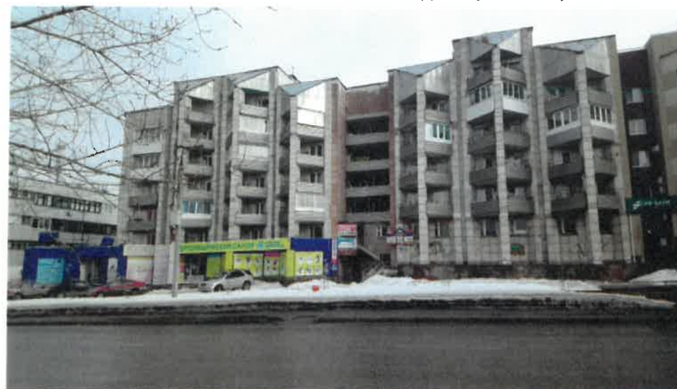
Существующее состояние главного фасада (фотофиксация).
