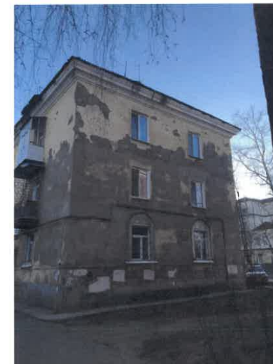
Существующее состояние бокового фасада (фотофиксация)
