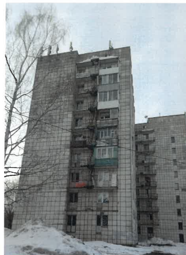
Существующее состояние бокового фасада (фотофиксация).
