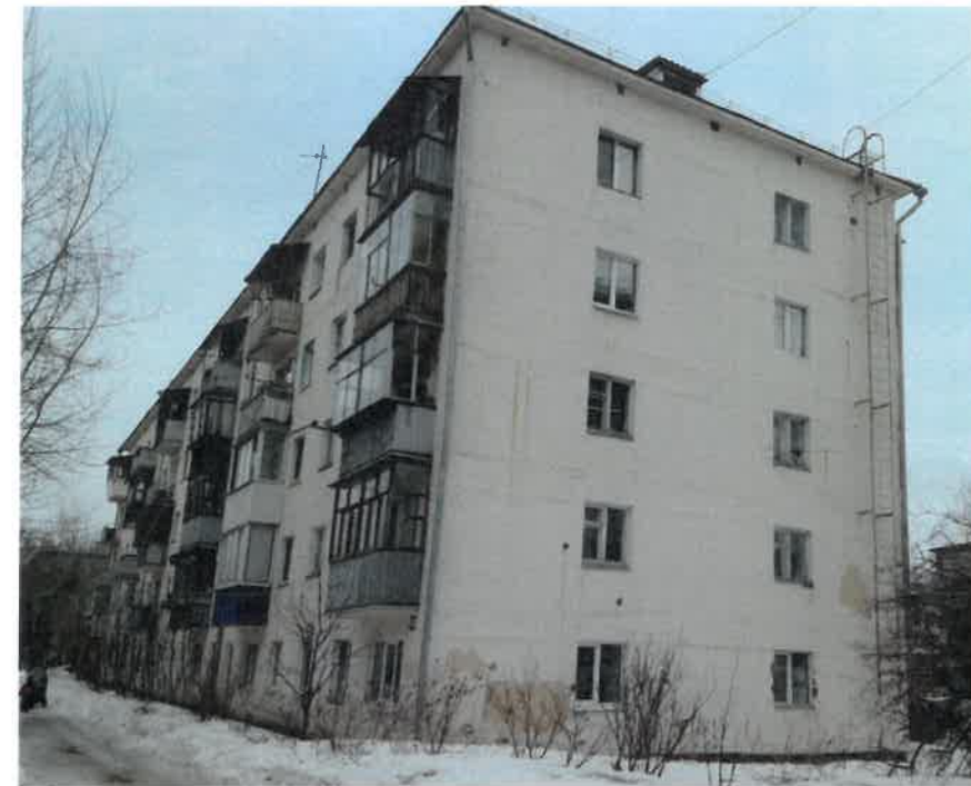
Существующее состояние бокового фасада (фотофиксация).
