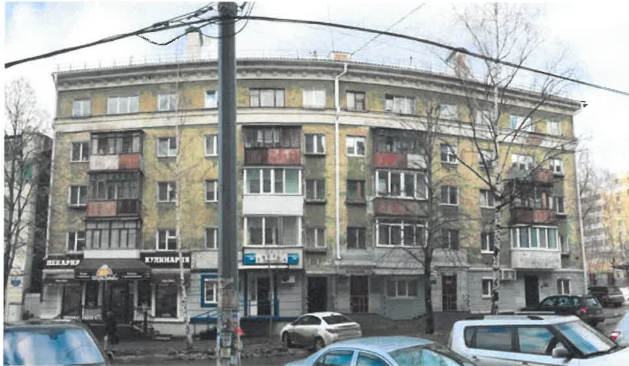
Существующее состояние главного фасада (фотофиксация)
