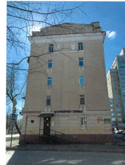
Существующее состояние бокового фасада (фотофиксация)
