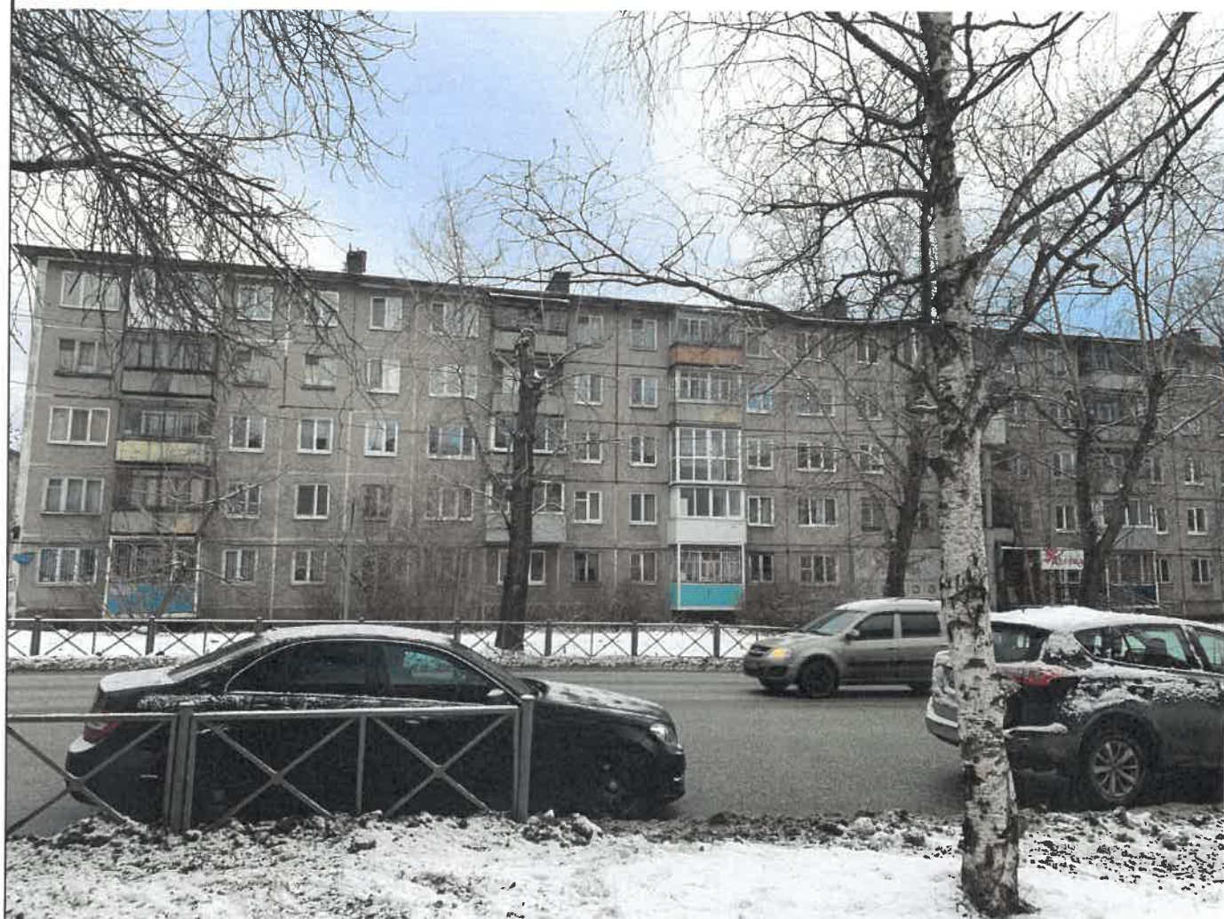
Существующее состояние главного фасада
