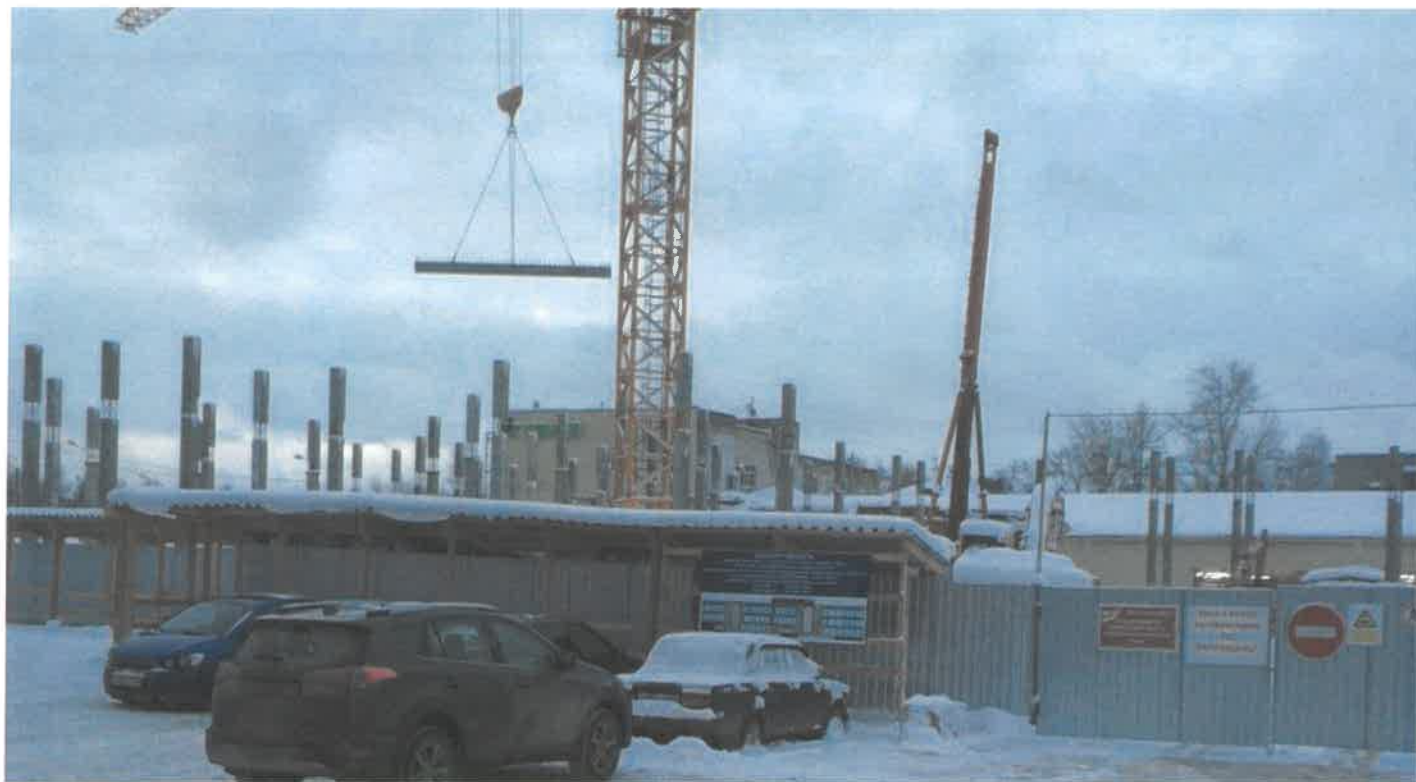
Боковой фасад (ул.Лодыгина)
