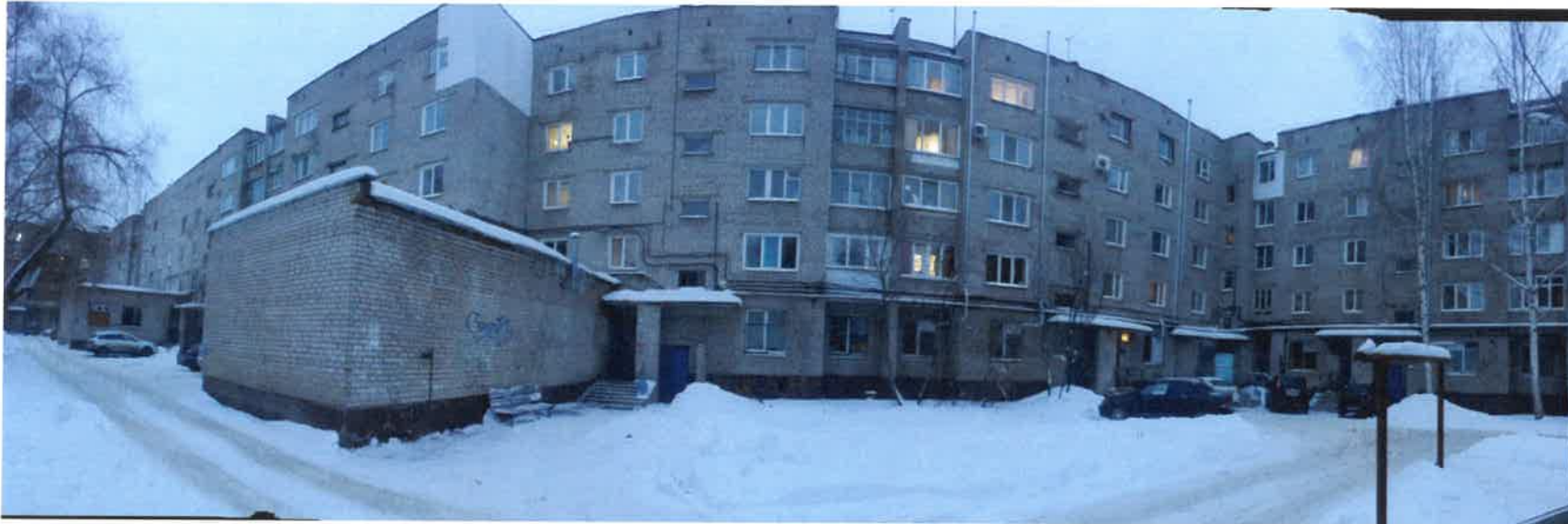
Существующее состояние дворового фасада (фотофиксация)
