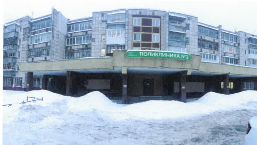
Существующее состояние главного фасада (фотофиксация)
