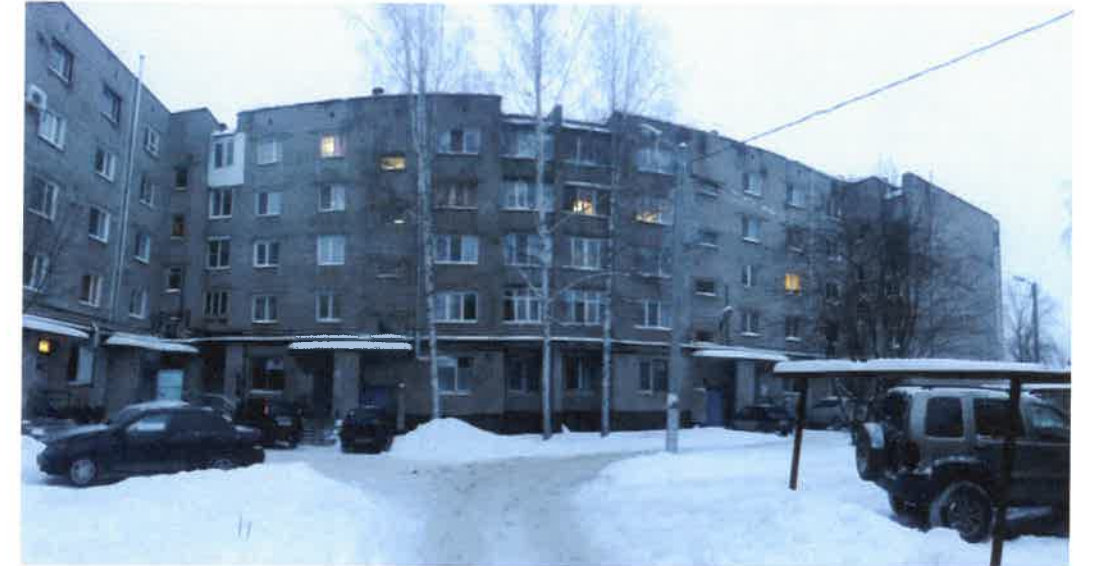
Существующее состояние дворового фасада (фотофиксация)
