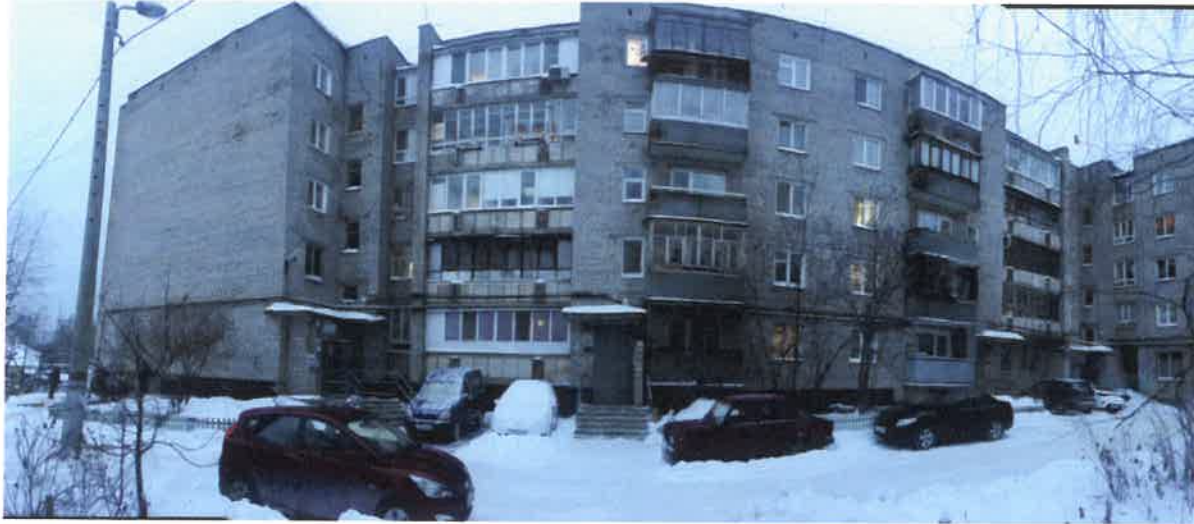
Существующее состояние дворового фасада (фотофиксация)
