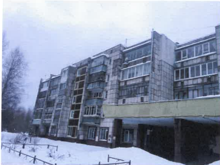
Существующее состояние главного фасада (фотофиксация)
