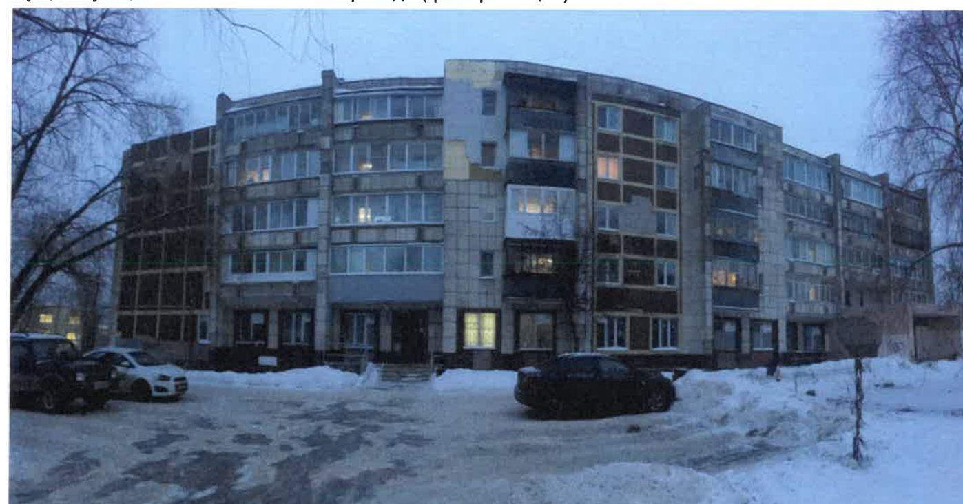
Существующее состояние бокового фасада (фотофиксация)
