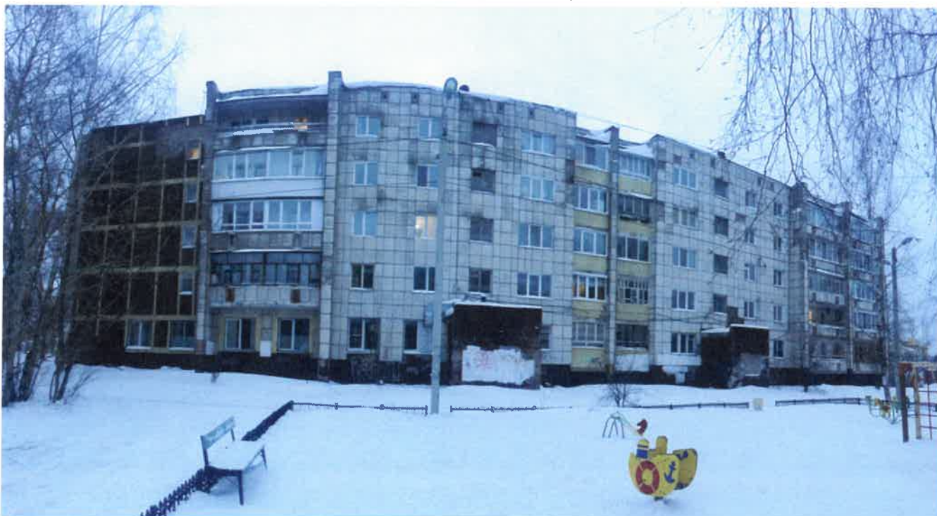
Существующее состояние бокового фасада (фотофиксация)
