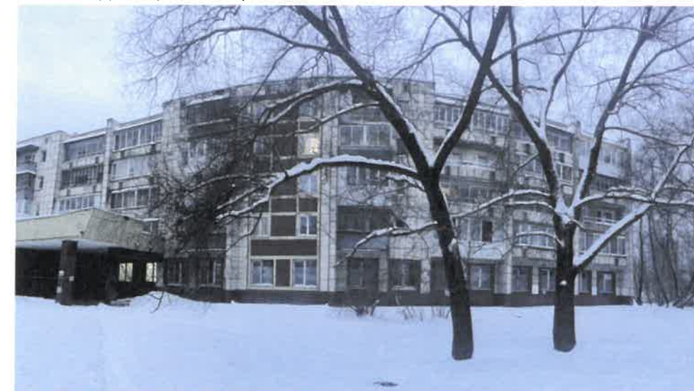
Существующее состояние главного фасада (фотофиксация)
