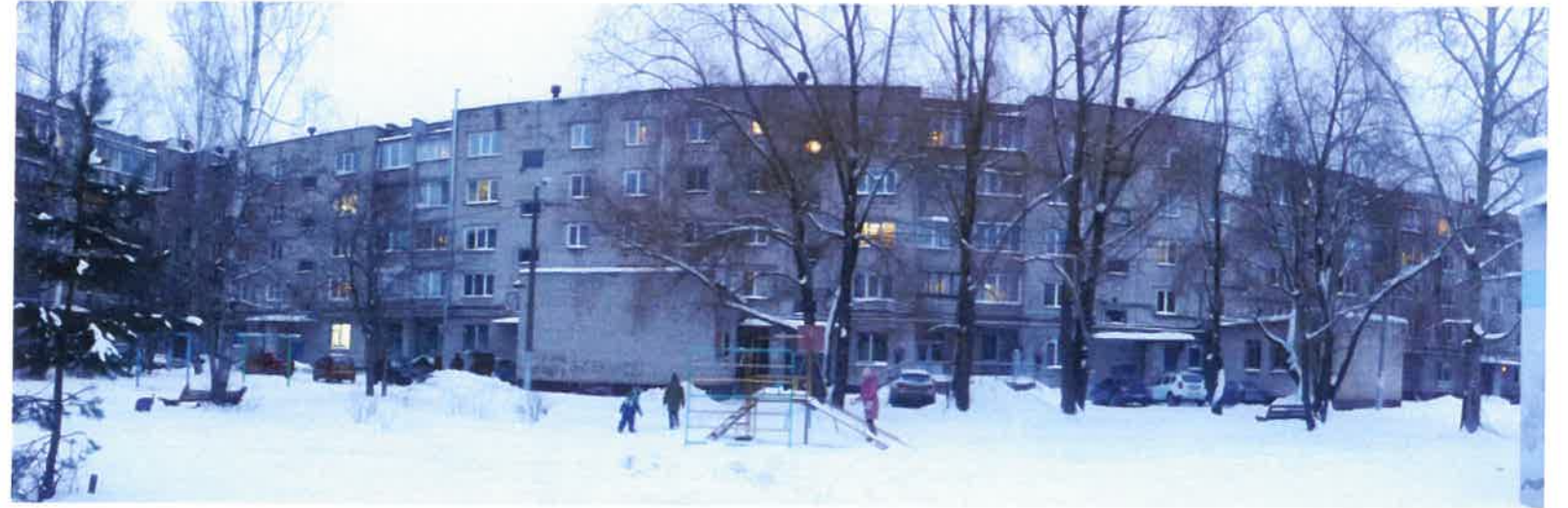
Существующее состояние дворового фасада (фотофиксация)
