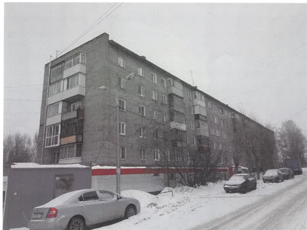
Существующее состояние главного фасада (фотофиксация)
