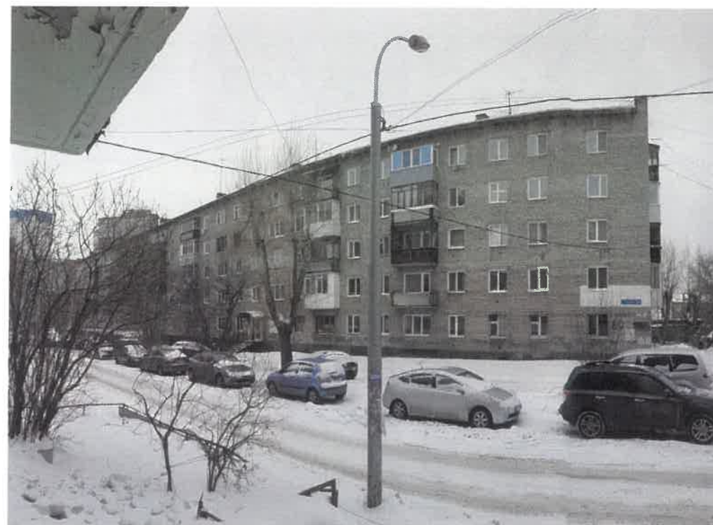
Существующее состояние главного фасада (фотофиксация)
