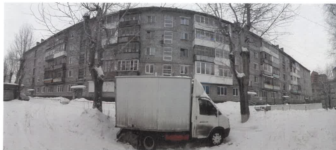
Существующее состояние дворового фасада (фотофиксация)
