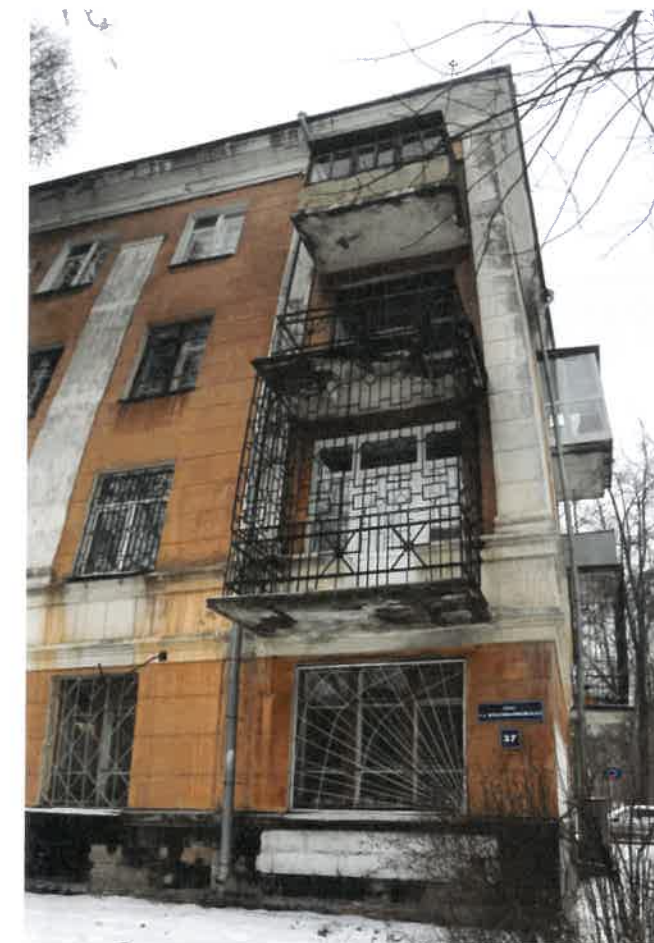
Существующее состояние главного фасада (фотофиксация)
