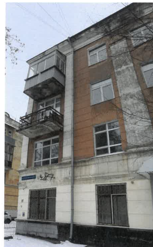
Существующее состояние главного фасада (фотофиксация)
