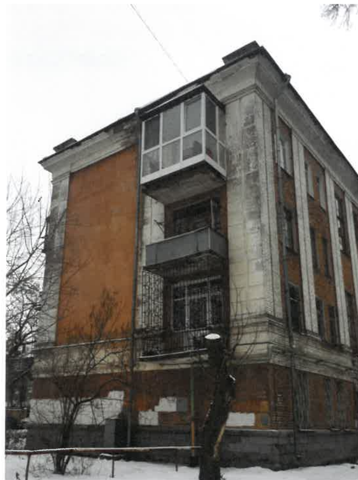
Существующее состояние бокового фасада (фотофиксация)
