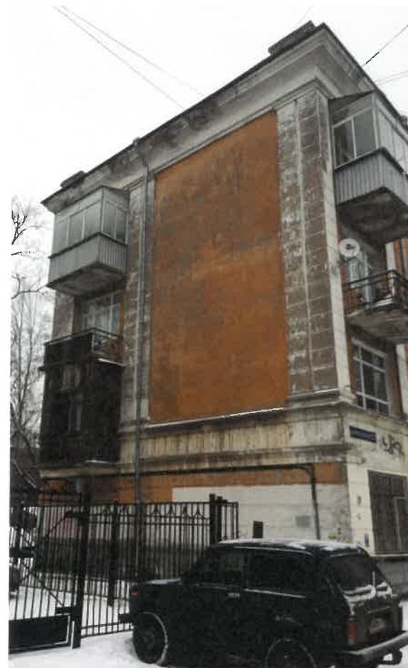
Существующее состояние бокового фасада (фотофиксация)
