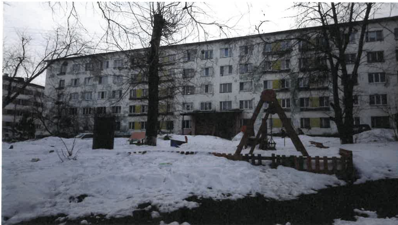
Существующее состояние главного фасада (фотофиксация).
