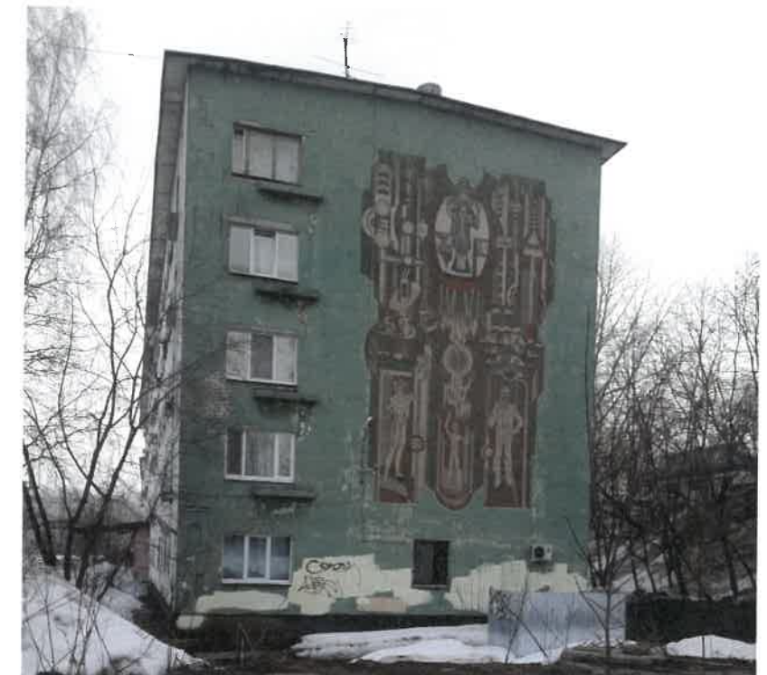
Существующее состояние бокового фасада (фотофиксация).
