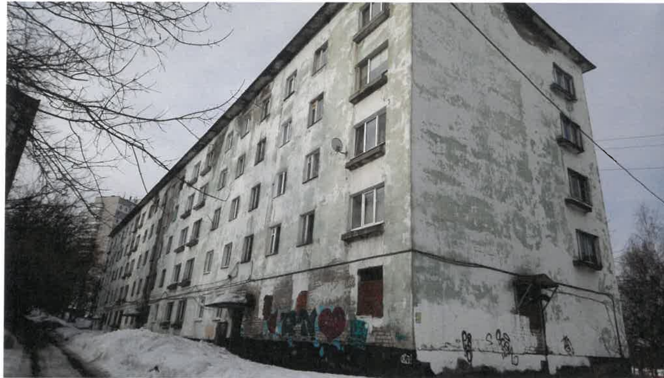
Существующее состояние дворового фасада (фотофиксация).
