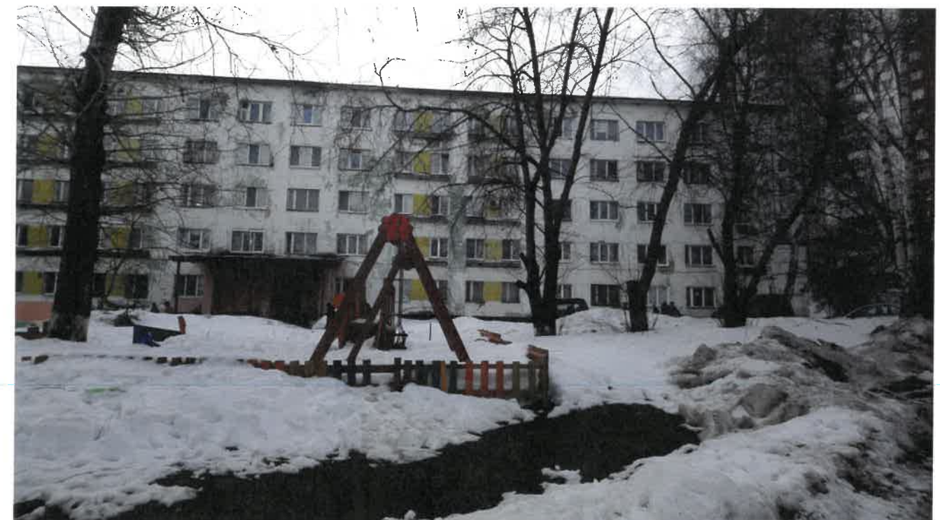
Существующее состояние главного фасада (фотофиксация).
