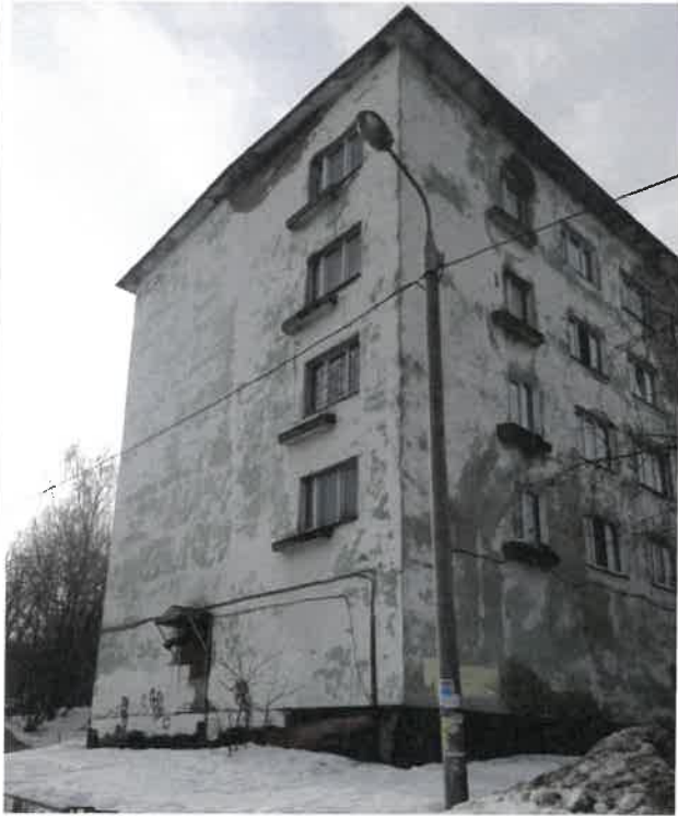
Существующее состояние бокового фасада (фотофиксация).
