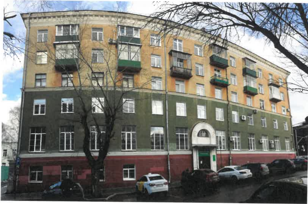
Существующее состояние главного фасада (фотофиксация)
