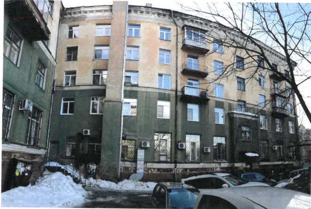
Существующее состояние дворового фасада (фотофиксация)
