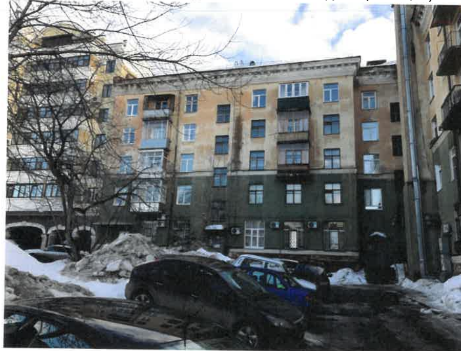
Существующее состояние дворового фасада (фотофиксация)
