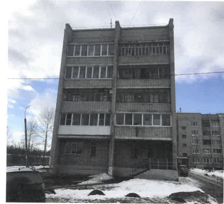
Существующее состояние бокового фасада (фотофиксация).
