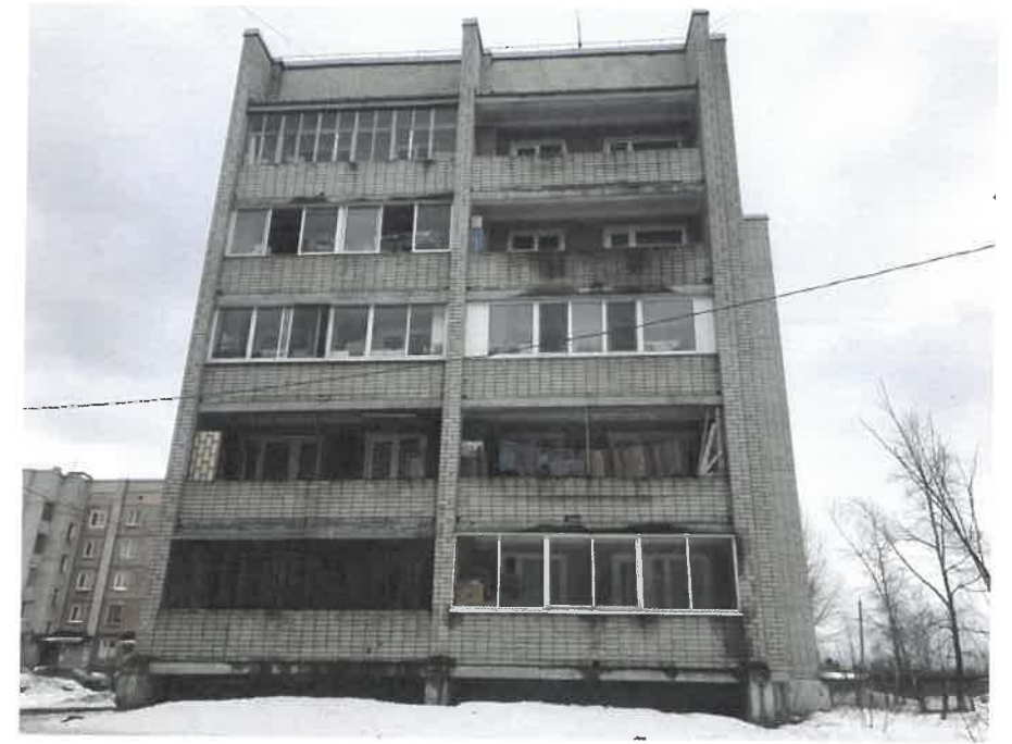
Существующее состояние бокового фасада (фотофиксация).
