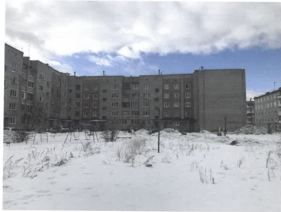
Существующее состояние дворового фасада (фотофиксация).
