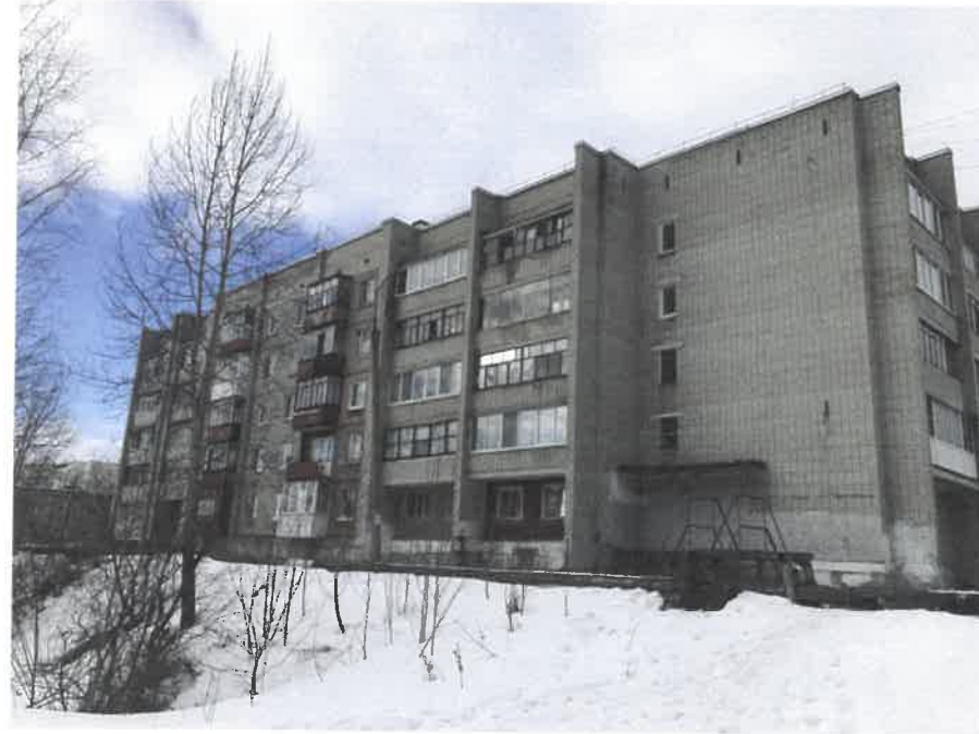
Существующее состояние главного фасада (фотофиксация).
