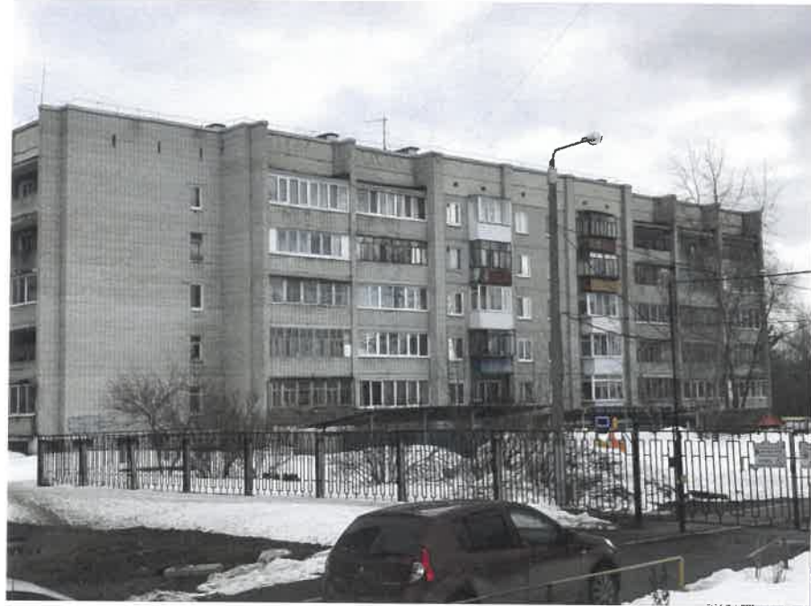
Существующее состояние главного фасада (фотофиксация).
