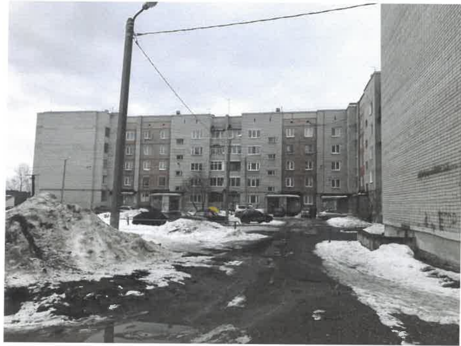
Существующее состояние дворового фасада (фотофиксация).
